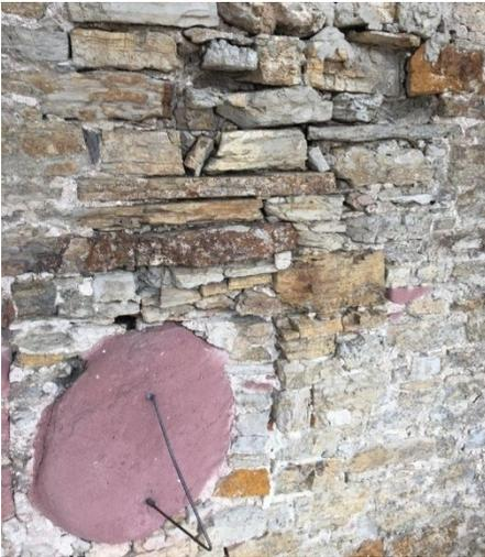
Das Turmmauerwerk vor dem Auskratzen der schadhaften Fugen. (Foto: A. Angerstein)
