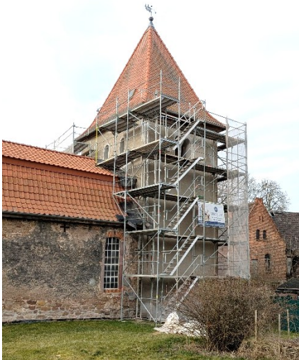
Der eingerüstete Kirchturm, an dem eifrig das schadhafte Mauerwerk saniert wird. (Foto: Indre Lange)
