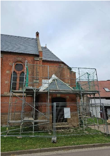
Momentan werden die Dächer aller Anbauten saniert. (Foto: Mareike Blischke)
