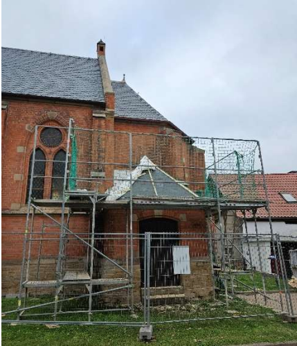
Momentan werden die Dächer aller Anbauten saniert. (Foto: Mareike Blischke)
