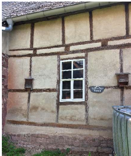
Der Fachwerkanbau mit dem sanierten Fenster. (Foto: Mareike Blischke)
