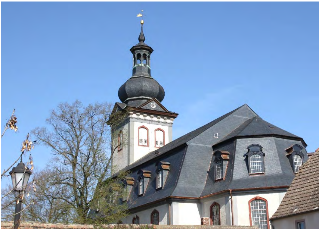
mit Abschluss der Baumaßnahme im April 2020, von Südosten.
