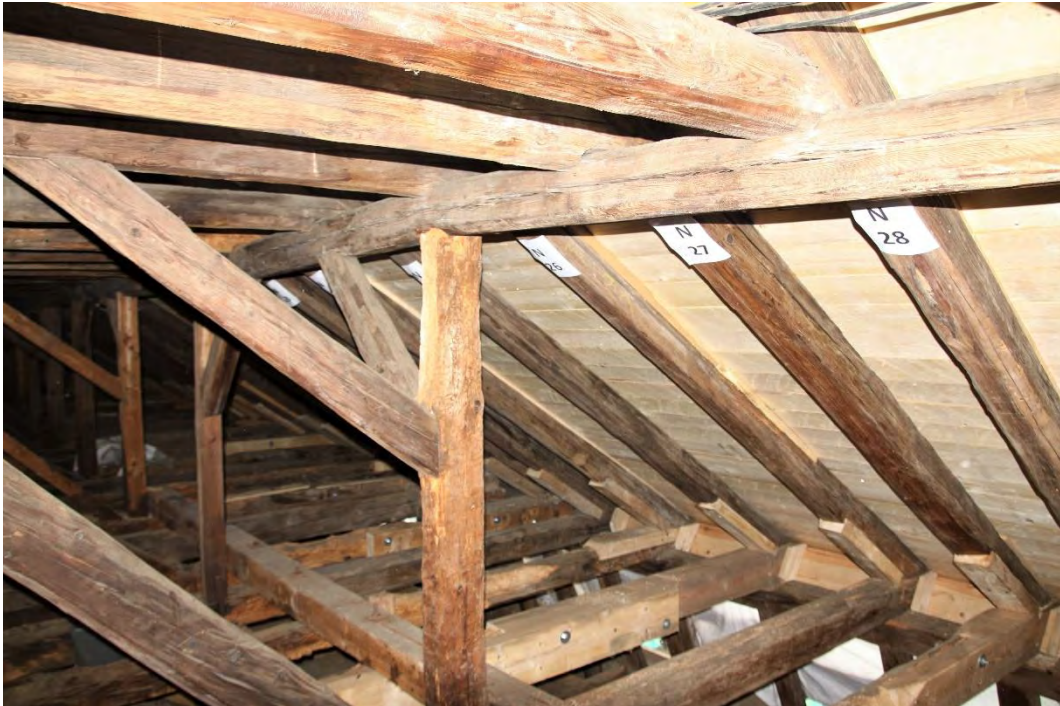
Der Dachraum vom Oberdach mit Abschluss der Holzinstandsetzung nach Nordwesten; die äußerst anspruchsvollen Sanierungsarbeiten am Dachtragwerk erfolgten denkmalgerecht unter der Prämisse maximalen Erhaltes der historischen Hölzer in hoher handwerklicher Qualität nach den Planungsvorgaben, November 2019.
