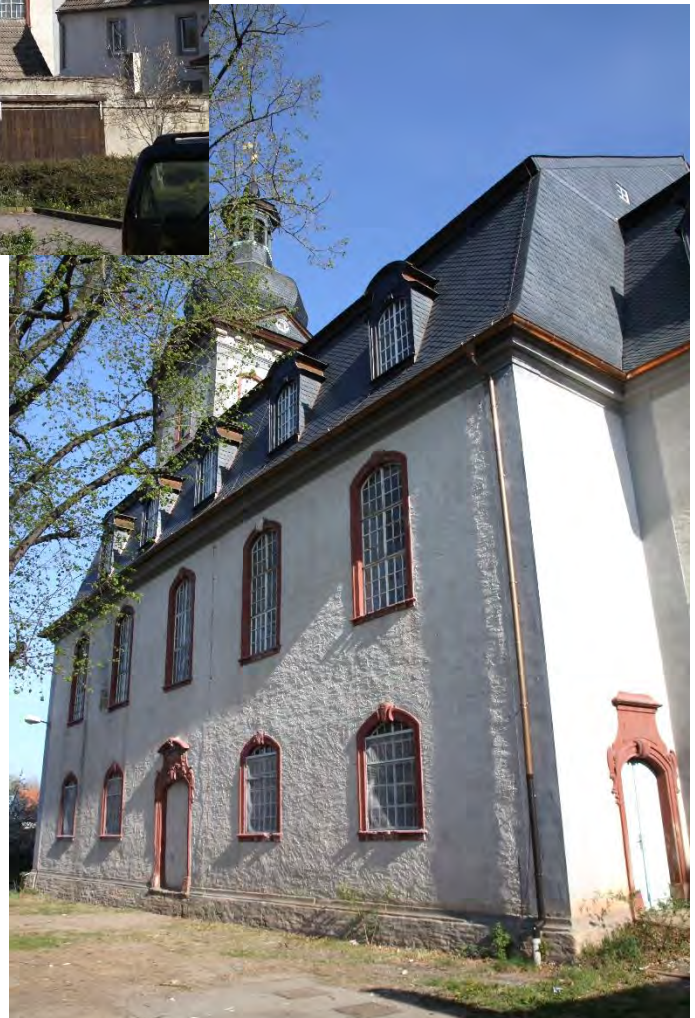
Das Kirchenschiff mit Bauabschluss nach Nordwesten, April 2020.
