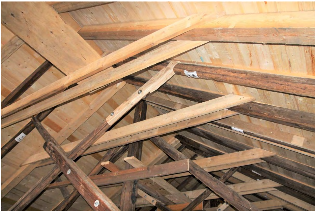
Der Firstbereich nach Westen; zur statischen Sicherung und Ertüchtigung wurden Zangen zwischen die Sparren eingebaut, November 2019.
