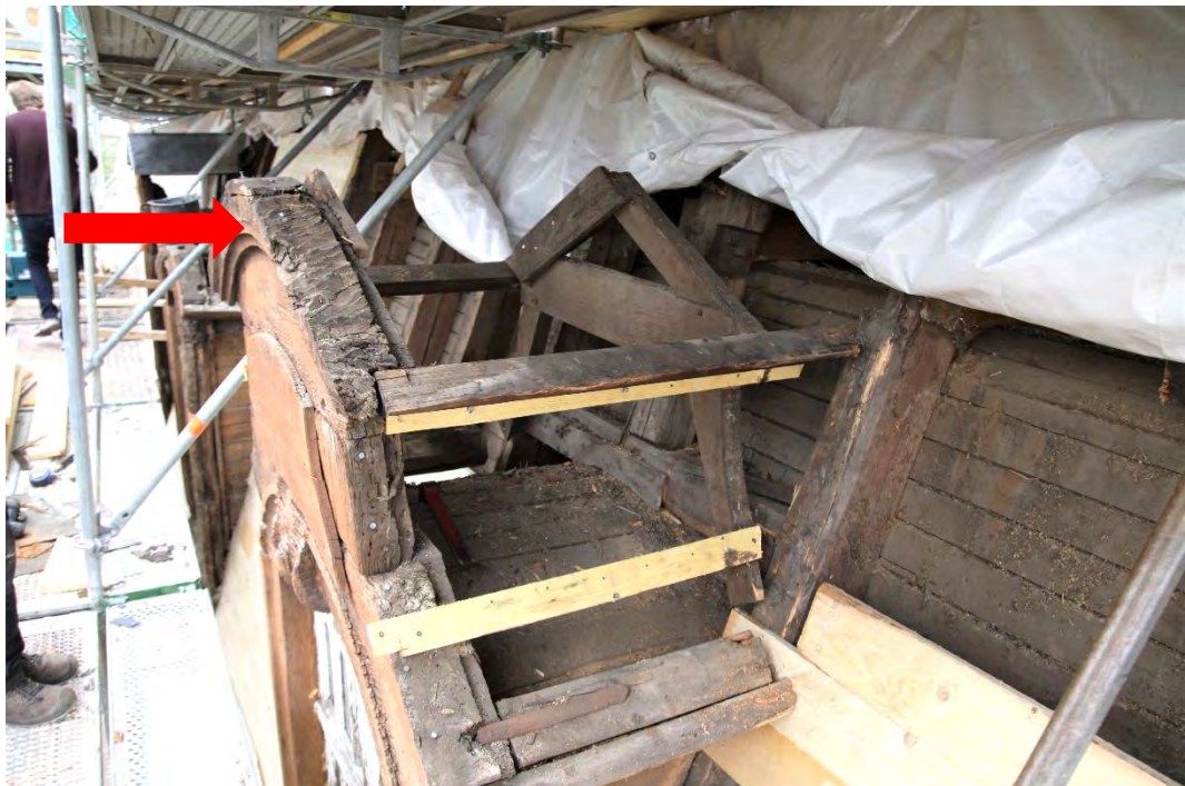
Dachgaube südliche Dachfläche, nach Abnahme Verblechung; die frontseitige, attikaartige Gaubenprofilierung wurde grob begradigt, Juli 2019.
