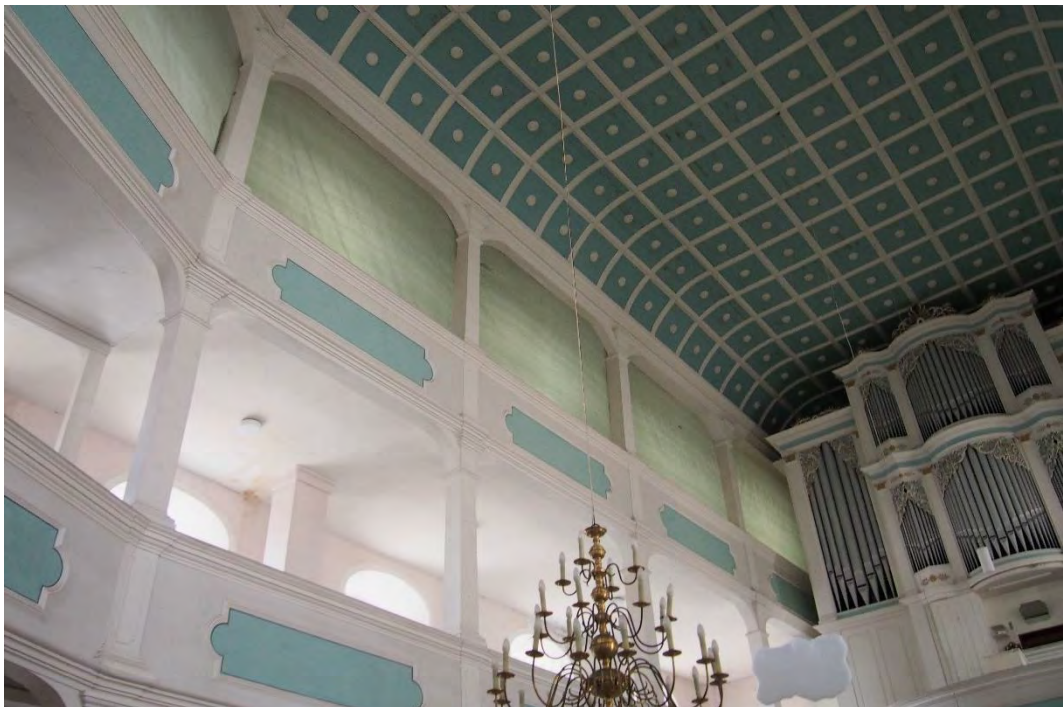
Der Innenraum der Kirche nach Südwesten; die obere Empore wurde zum Schutz der Einrichtung vor Verunreinigungen mit Folie staubdicht abgedichtet, Februar 2019.
