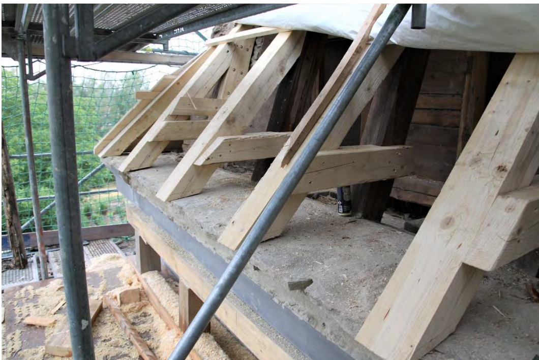
Südlicher Traufbereich Unterdach – Südwestecke nach Westen; statisch-gesichertes und wiederhergestelltes Hauptgesims und instand gesetzte Dachkonstruktion; zur Entlastung des auskragenden Gesimses wurden Kragbalken zwischen Sparren und Aufschieblinge eingebaut, Juli 2019.
