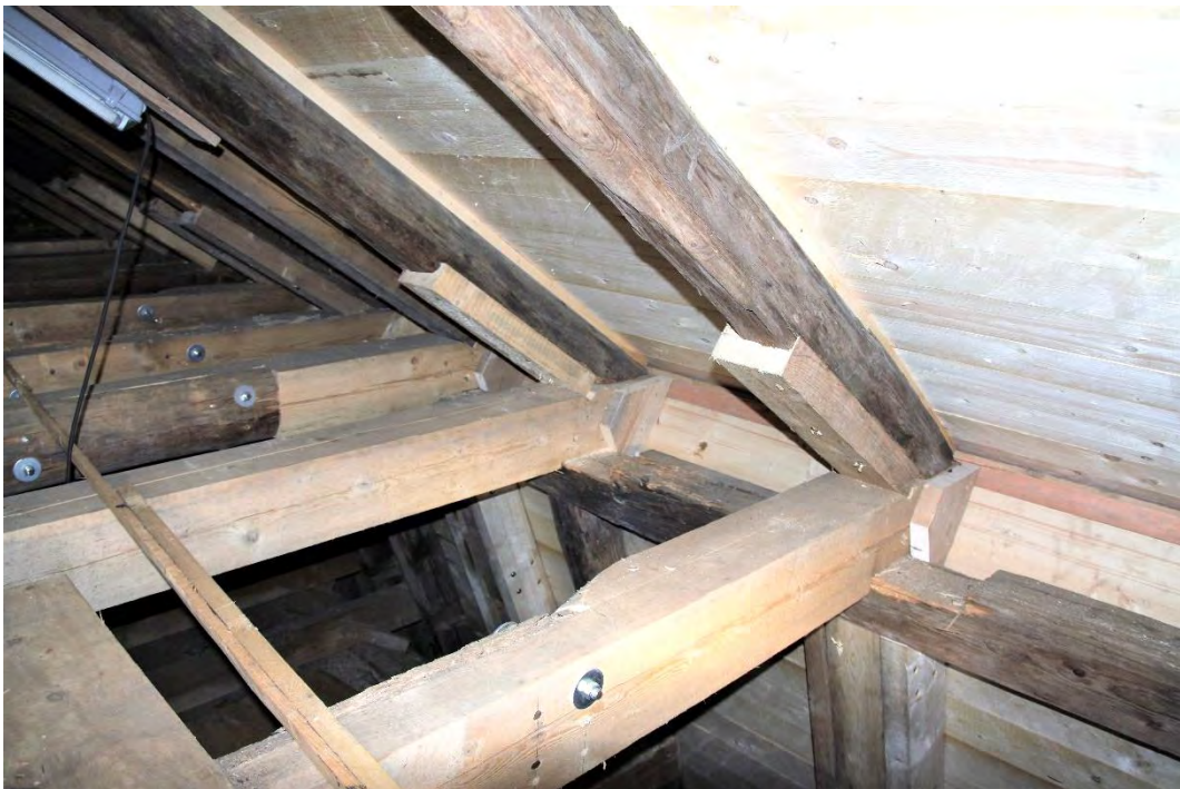
Nördliches Oberdach, Detailaufnahme Holzinstandsetzung/-ersatz, November 2019.
