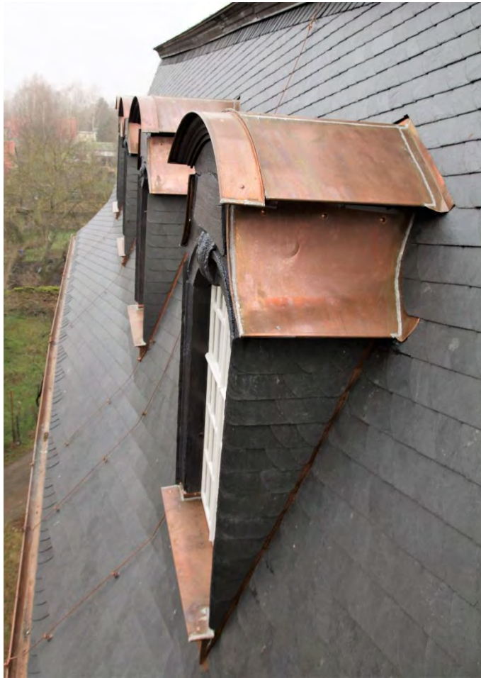
Die instand gesetzten südlichen Dachgauben nach Westen.
