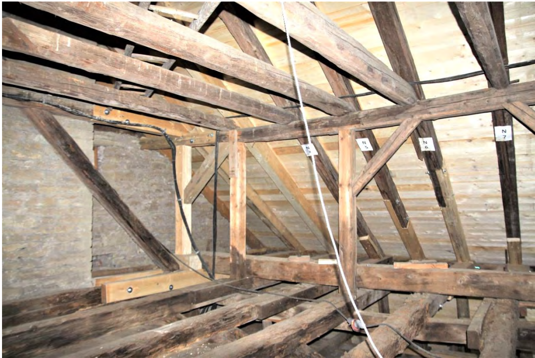
Blick in die Nordwestecke vom Oberdach mit Abschluss der Holzinstandsetzung, aufgenommen im November 2019.
