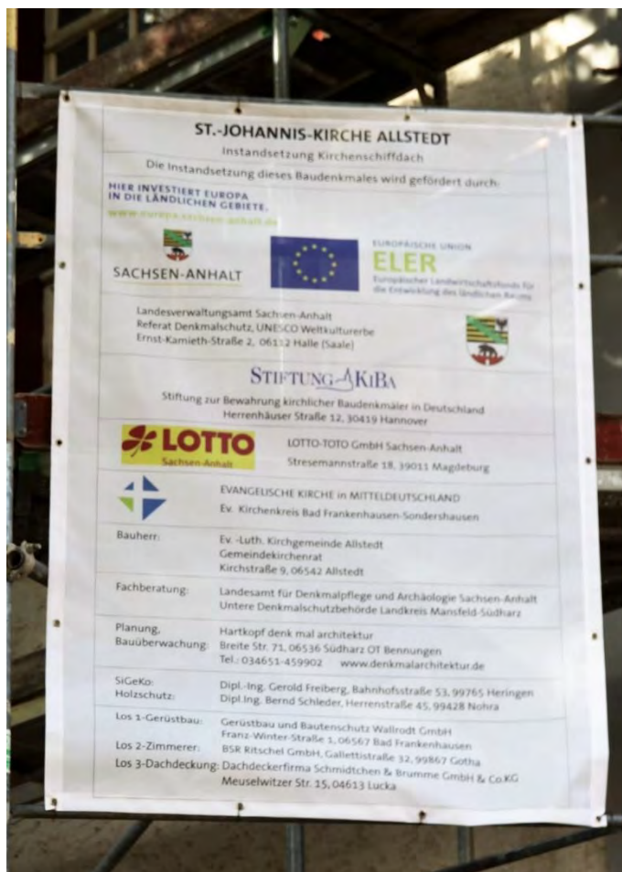
Das Baustellenschild mit Angabe der Förderer und Projektbeteiligten, Februar 2019.
