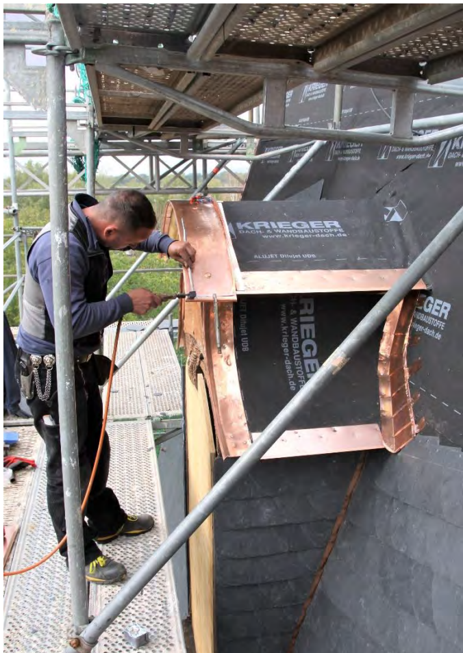
Dachgaube, während der Montage der Blechabdeckung, Oktober 2019.
