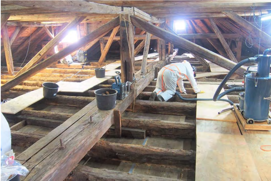
Der Dachraum vom Kirchenschiff während der aufwendigen Dekontaminierungsarbeiten nach Osten, Februar 2019.
