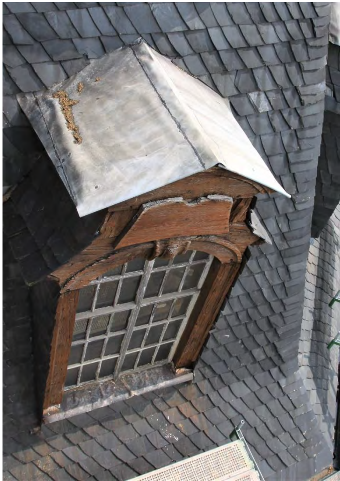
Kirchenschiffdach, östliche Dachgaube südliche Dachfläche vor Beginn der Instandsetzungsarbeiten am südlichen Unterdach.
