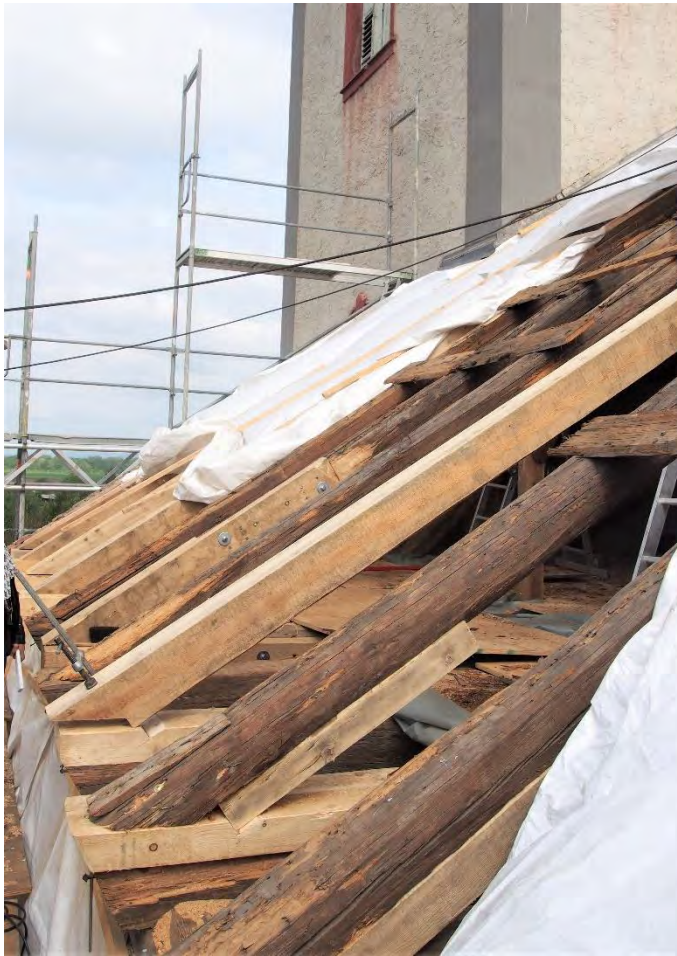
Das südliche Oberdach während der handwerklichen Holzinstandsetzung nach Westen, Mai 2019.
