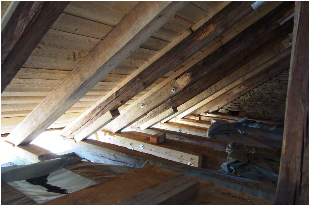
Die instand gesetzte Holzkonstruktion in der Südwestecke des Oberdaches, Juni 2019.
