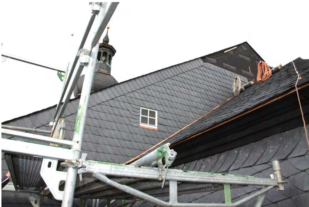
Der östliche Dachgiebel vom Kirchenschiff während der Verschieferung, Februar 2020.
