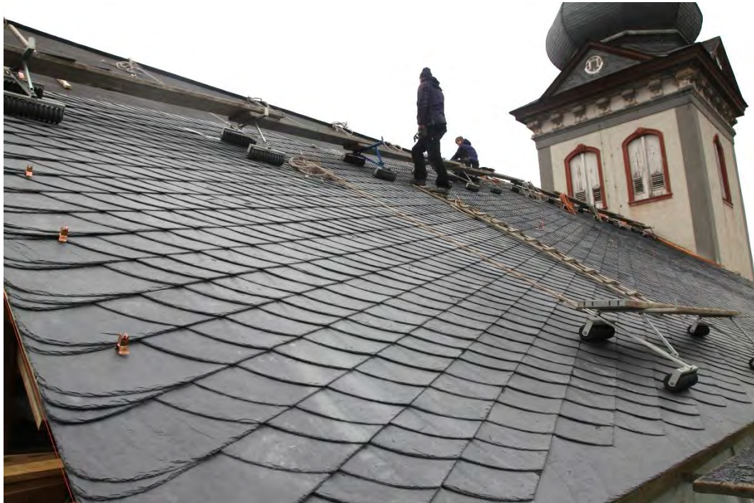
Das nördliche Oberdach während der Eindeckung mit Naturschiefer als altdeutsche Deckung, November 2019.
