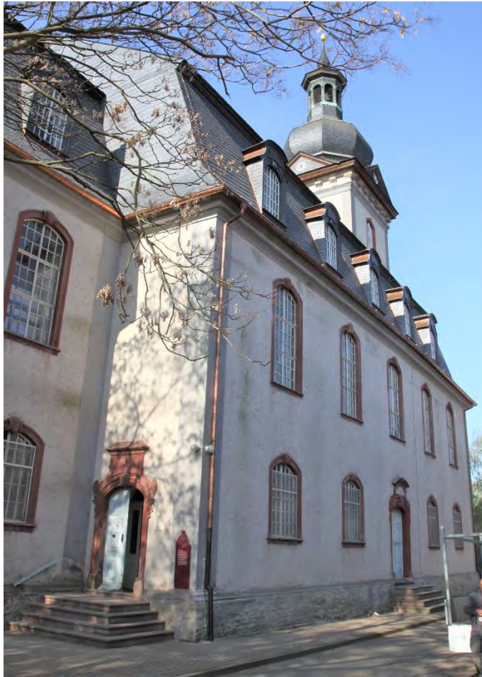
Nordansicht vom Kirchenschiff mit Abschluss der Sanierungs- arbeiten aus nordöstlicher Richtung, April 2020.
