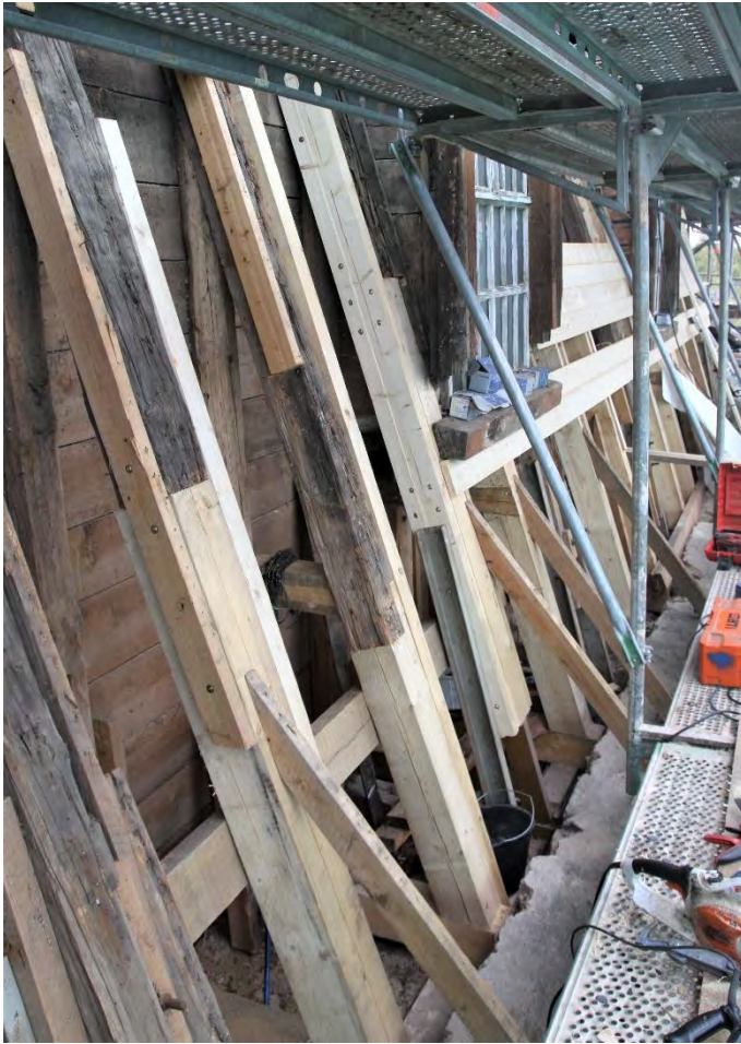
Die Dachkonstruktion vom nördlichen Unterdach während der holzseitigen Instandsetzung und statischen Ertüchtigung, nach Westen, September 2019.
