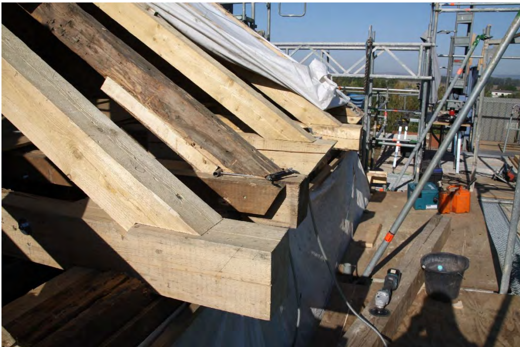
Der Traufbereich vom nördlichen Oberdach während der Sanierungsarbeiten nach Westen, September 2019.
