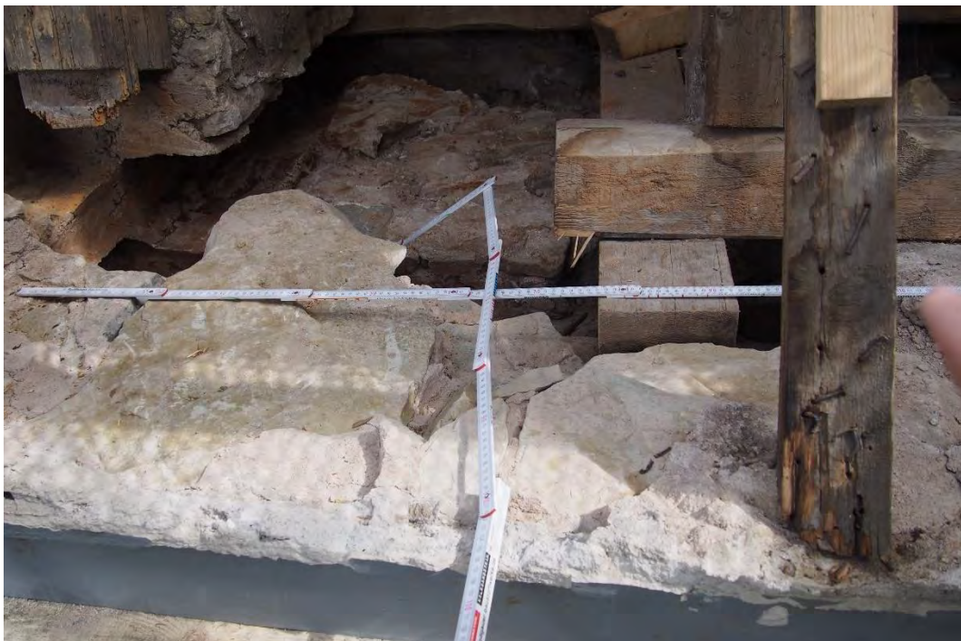
Das südliche Hauptgesims in der Südwestecke nach dem Abtrag der oberen Steinschichten; zwischen den Deckenbalken wurde eine ca. 50-60cm tiefe Steinplatte als Krag- bzw. Binderstein mit dem innenseitigen Mauerwerk vermauert; in den unteren Steinschichten sind keine Schwammmyzele mehr erkennbar, Mai 2019.
