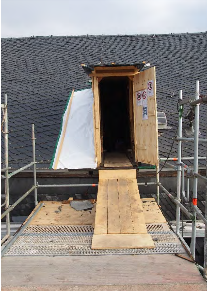
Kirchenschiff, südliches Oberdach; Arbeitsplattform und Dach- einstieg für die Dekonta- minierungsarbeiten, aufge- nommen im Februar 2019.
