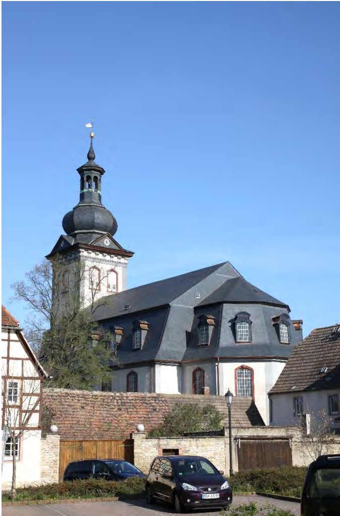
Gesamtansicht der St.-Johannis-Kirche Allstedt mit Abschluss der Sanierung des Kirchenschiffdaches aus südöstlicher Richtung, April 2020.
