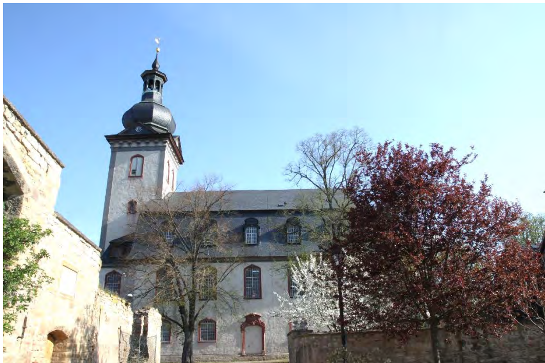
Die St. Johannis Kirche mit Bauabschluss von Süden, April 2020.
