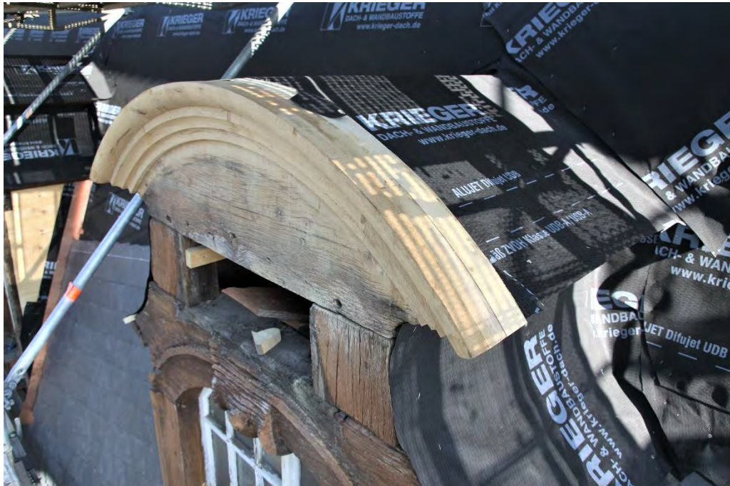
Dachgaube südliche Dachfläche, nach historischer Vorgabe wiederhergestellte Gaubenprofilierung, September 2019.
