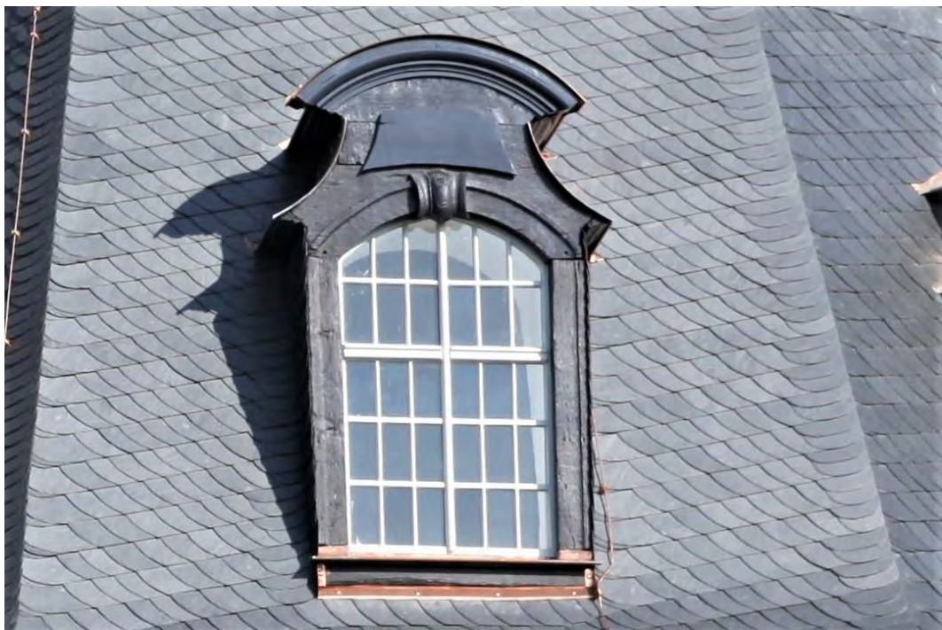
Dachgaube mit restauriertem Holzsprossenfenster, April 2020.
