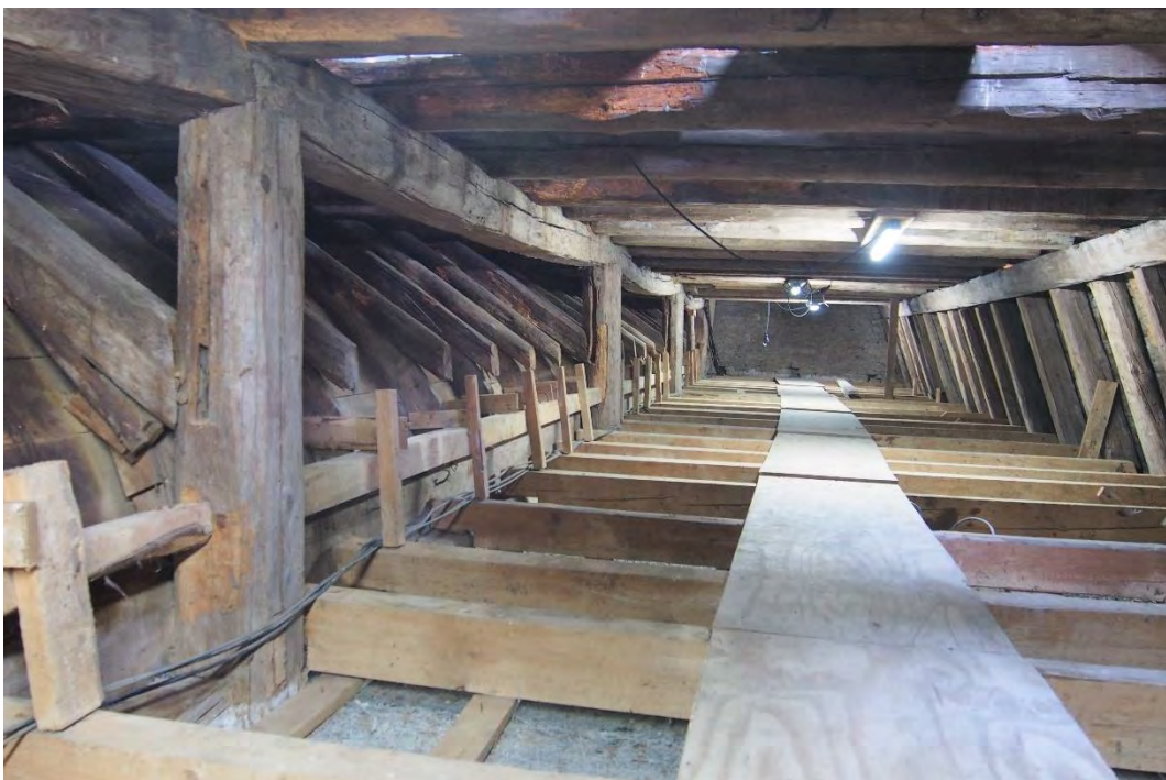
Kirchenschiff, nördliche Dachhälfte, mit Abschluss der Dekontaminierung und Spezialreinigung nach Westen, März 2019.
