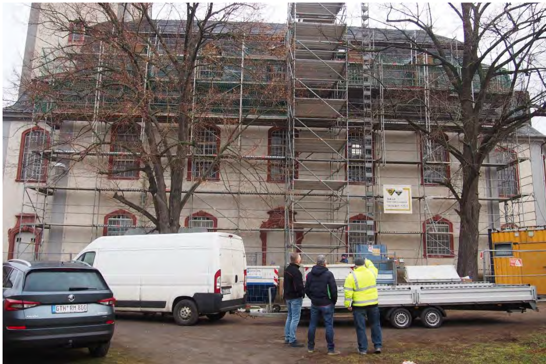
Das eingerüstete Kirchenschiff der St.-Johannis-Kirche Allstedt zu Beginn der Sanierungsarbeiten von Süden, Februar 2019.
