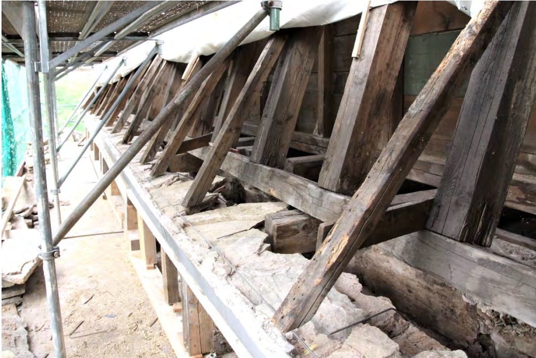
Das südliche Hauptgesims während der Wiederherstellung der oberen Steinschichten, nach Westen; zur statischen Sicherung und Verankerung des Gesimses wurden Längs- und Quereisen in die Aufmauerung integriert und mit den Deckenbalken verbunden, Juni 2019.
