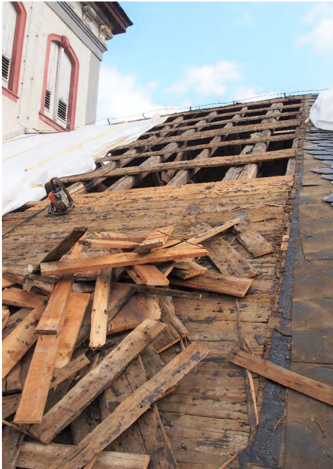
Das südliche Oberdach vom Kirchenschiff während der Freilegung nach Norden, aufgenommen im April 2019.
