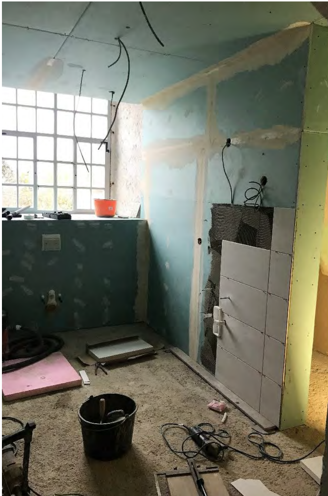
Blick in das barrierefreie WC im EG des südlichen Turmanbau während der Verlegung der Wandfliesen, nach Westen, November 2024.
