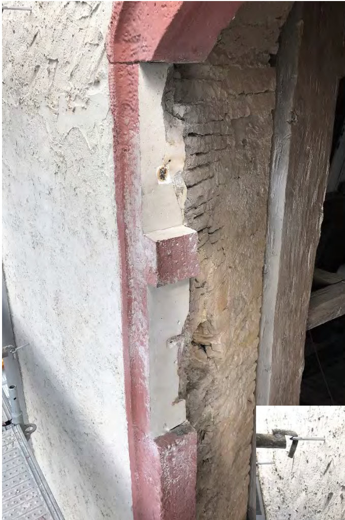
Westliche Schallöffnung, nördliches Gewände, vorbereitet für den Einbau der Vierungen, April 2024.
