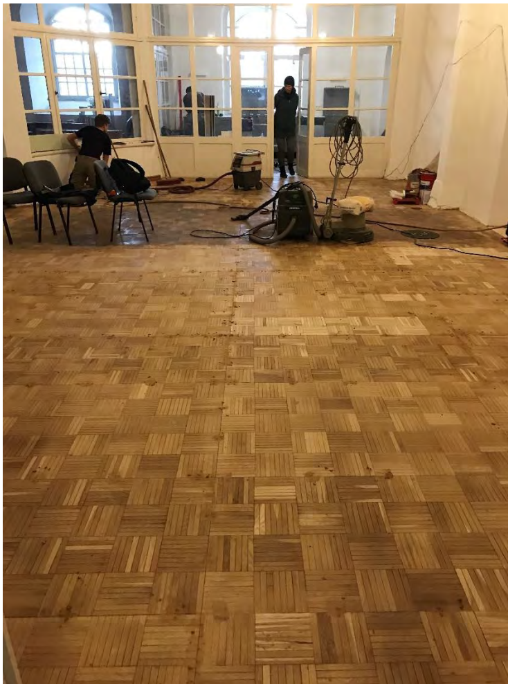
Winterkirche, während der Instandsetzung und Aufarbeitung des Parkettbodens, nach Süden, Dezember 2024.
