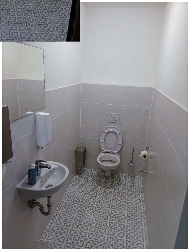
Das erneuerte WC im Sanitärtrakt nach Westen, aufgenommen im Februar 2025.
