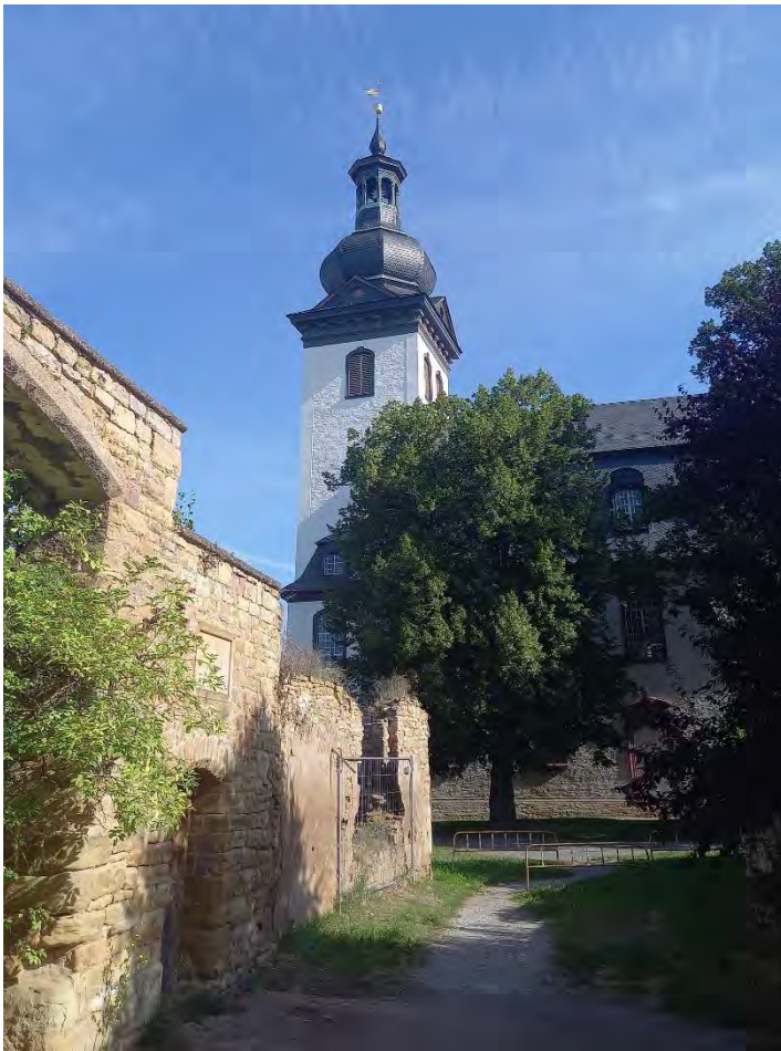
Blick auf die St. Johannes Kirche aus südöstlicher Richtung, August 2024.
