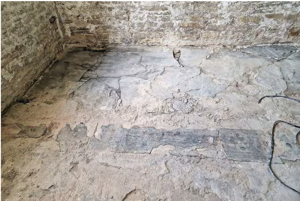
Der wahrscheinlich bauzeitliche Fußboden im EG südlicher Turmanbau nach Norden, aufgenommen im August 2024.
