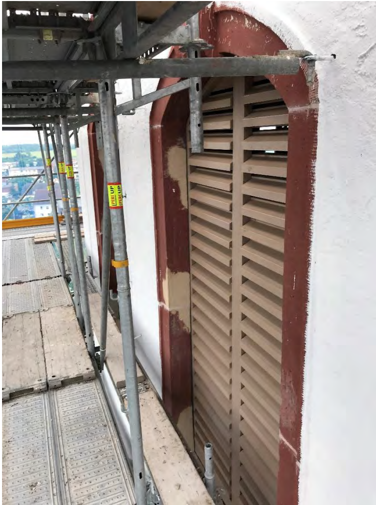
Schallöffnungen Turmostseite, nach Süden; Instand gesetzte Gewände und erneuerte Schallluken, aufge- nommen im Mai 2024.
