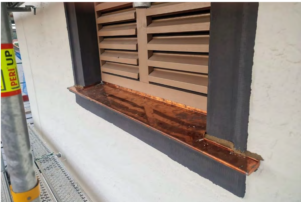
Westliche Schallöffnung, mit Kupferblech verwahrte Fensterbank, Juni 2024.
