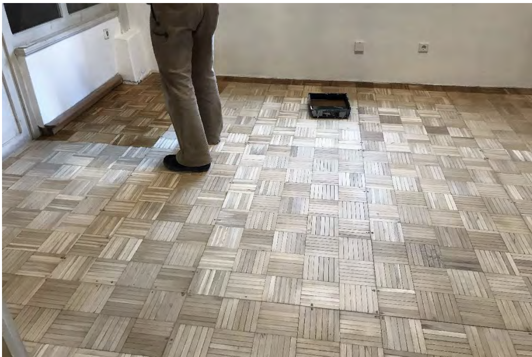
Imprägnierung des aufgearbeiteten Parkettbodens in der Winterkirche, Dezember 2024.
