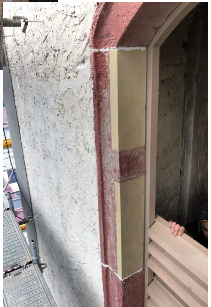
Nördliches Gewände mit exakt eingepasster Vierung, Mai 2024.
