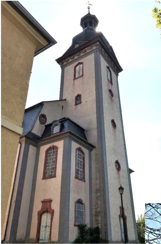
Der Kirchturm mit nördlichem Turmanbau vor Baubeginn und
