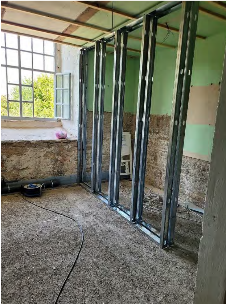
Erdgeschoss südlicher Turmanbau während der Montage der Trennwände, September 2024.
