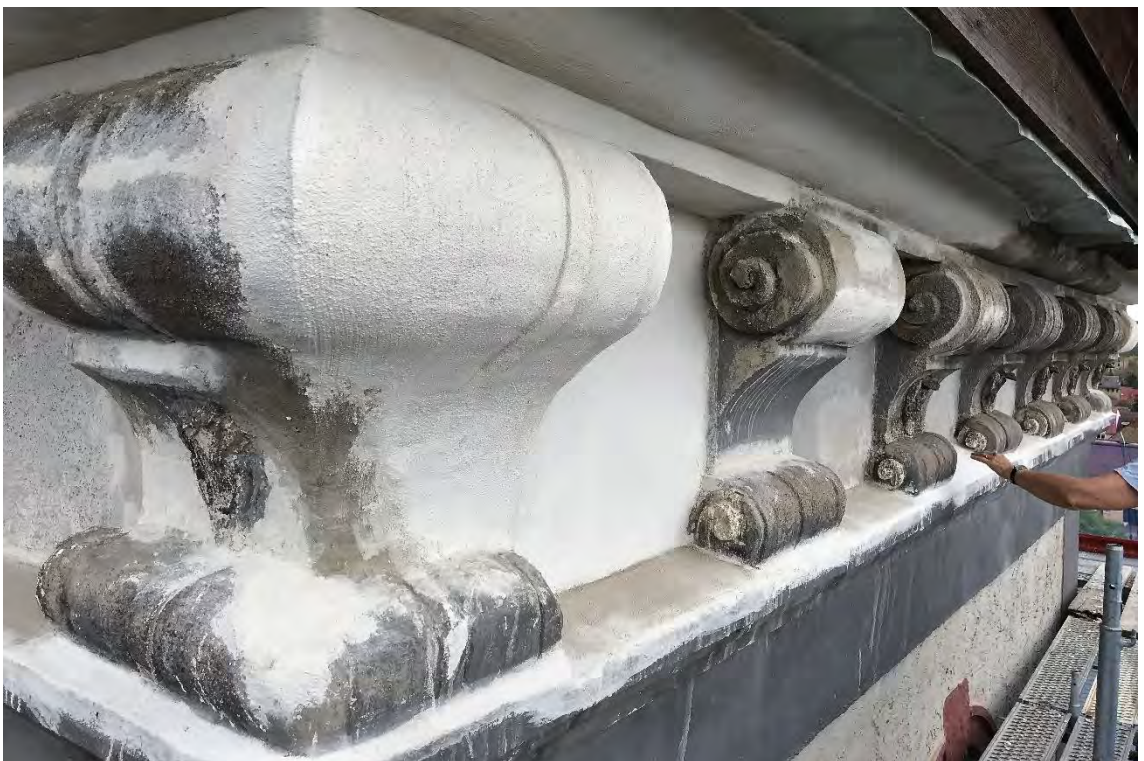
Stuckkonsole Hauptgesims mit wiederhergestelltem Medaillon, Juni 2024.
