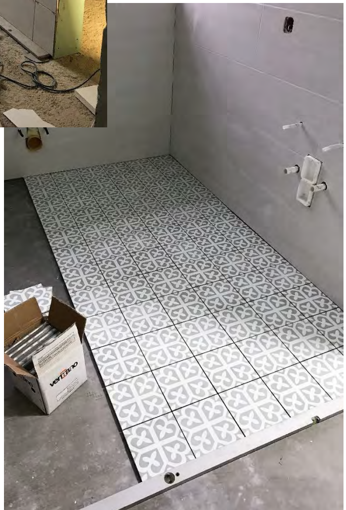
Verlegung der Fußbodenfliesen im barrierefreien WC, Dezember 2024.
