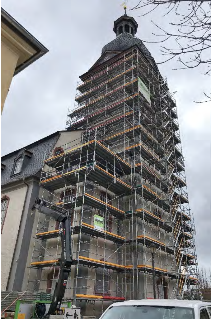
Der eingerüstete Kirchturm zu Beginn der Instandsetzungsarbeiten im Februar 2004.
