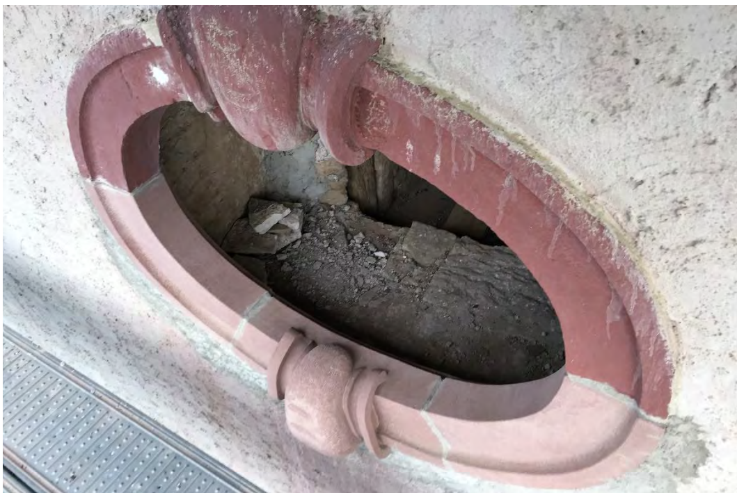
Turmwestwand, mittleres Ochsenauge, die untere Hälfte des Gewändes wurde erneuert, aufgenommen im Mai 2024.
