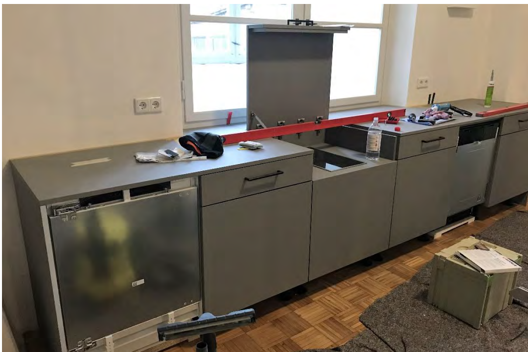
Montage der Küchenzeile, Dezember 2024.
