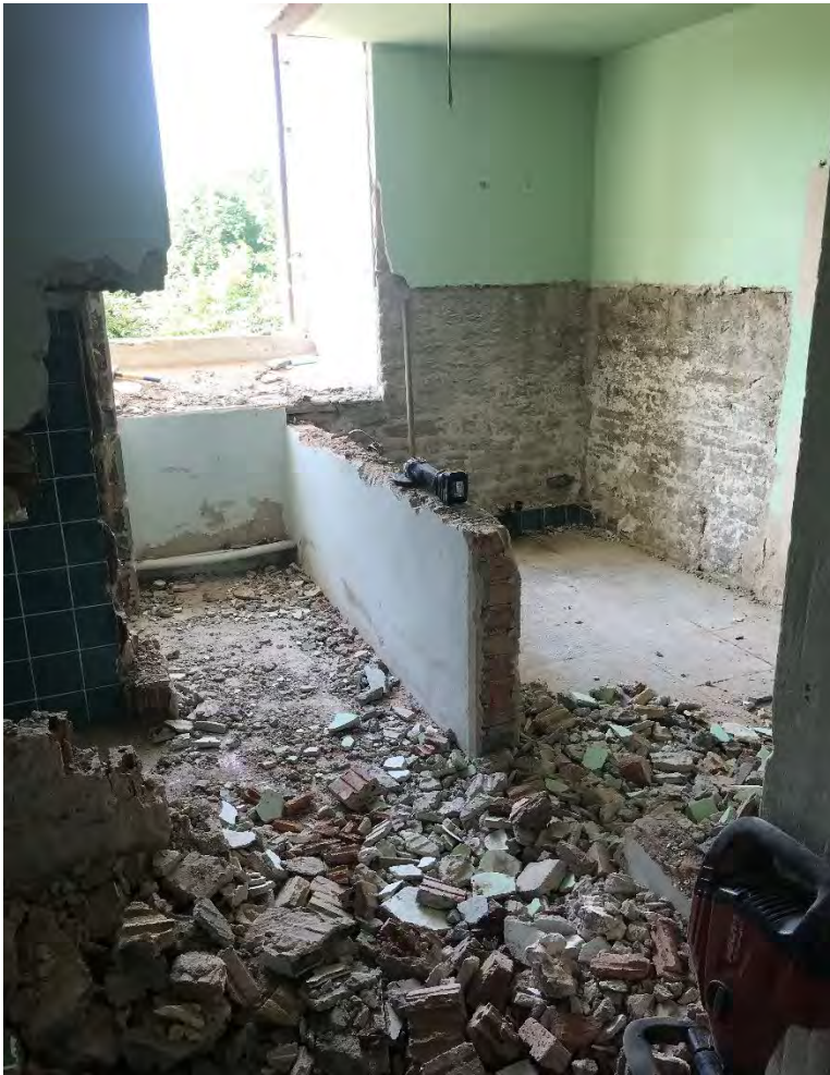
Blick in den Sanitärraum im EG des südlichen Turmanbaues während der Abbruch- bzw. Rückbauarbeiten, nach Westen, Juli 2024.
