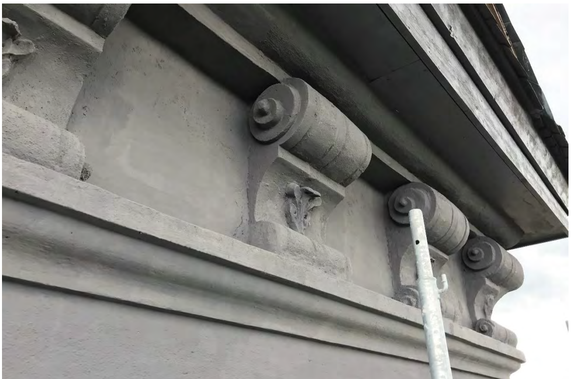
Das westlich Hauptgesims mit restaurierten Stuckkonsolen, die Medaillons sind oxydrot abgesetzt, aufgenommen im Juni 2024.
