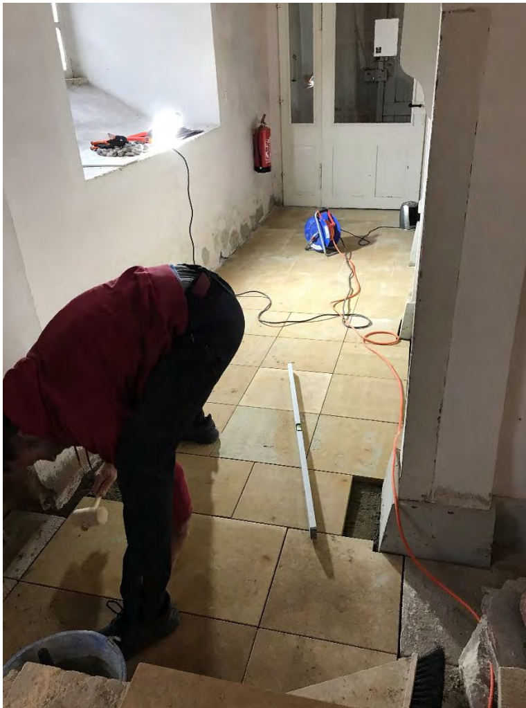
Kirchenschiff, Instandsetzung bzw. Erneuerung schwer ge- schädigter Fußbodenplatten, Dezember 2024.
