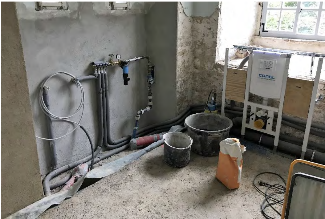
Sanitärraum im EG südlicher Turmanbau während der Sanitärinstallationen, Oktober 2024.
