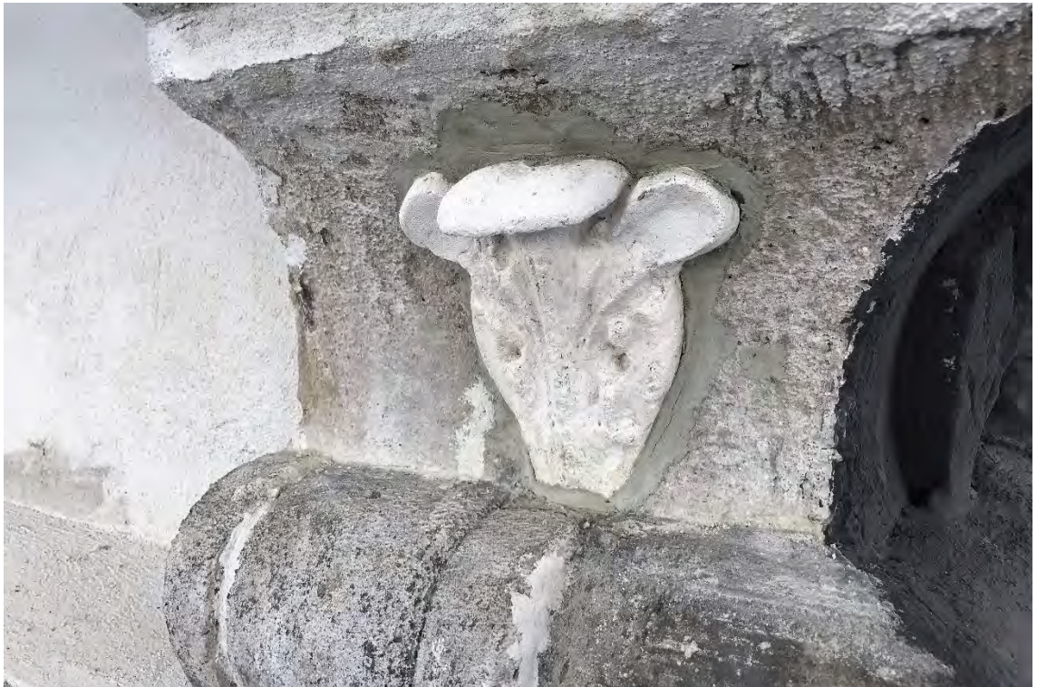
Südliches Hauptgesims mit instand gesetzten Stuckkonsolen, nach Osten, April 2024.
