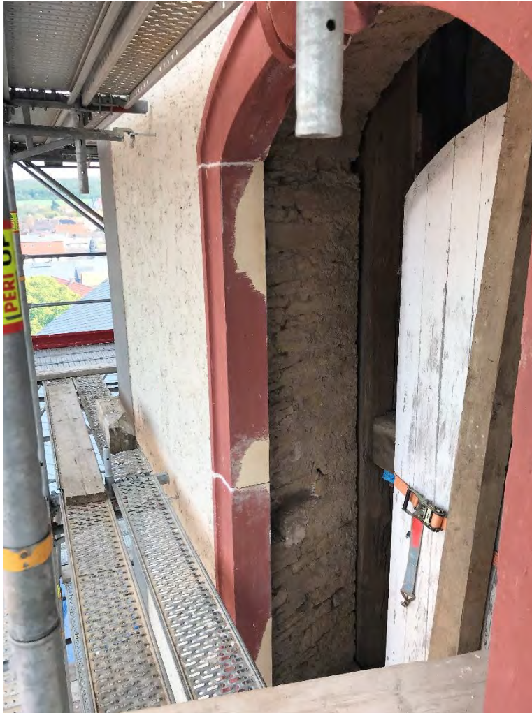
Nördliche Schallöffnung, östliches Gewände; Steinergänzungen mittels Steinersatzmasse, April 2024.
