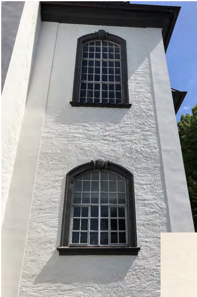
Die Westwand vom südlichen Turmanbau mit restaurierten Holz-sprossenfenster.
