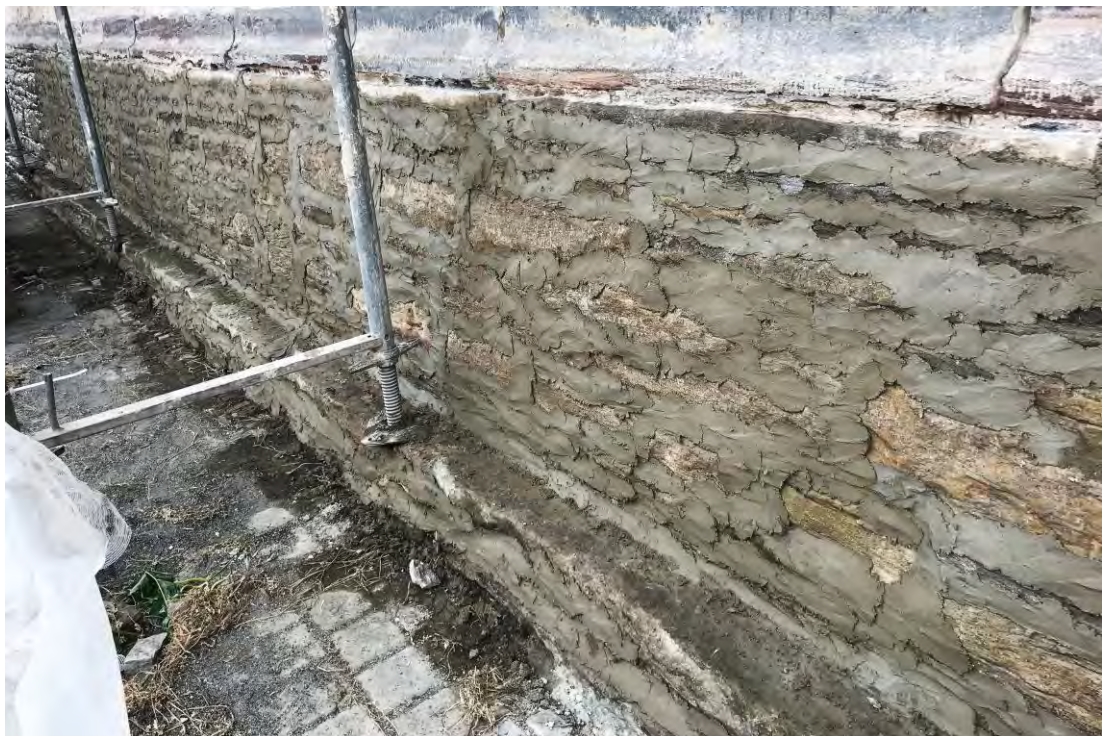
Das Sockelmauerwerk der Langhausnordwand während der Verfugung nach Südosten, nach dem Anziehen wurde der Mörtel auf den Stein zurückgekratzt, Mai 2025.
