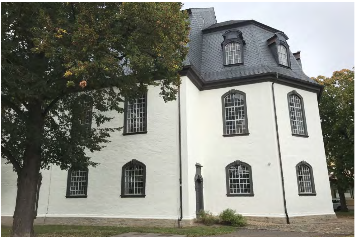
Langhaus und Chor mit Abschluss der Fassadeninstandsetzung von Süden, Juli 2025.
