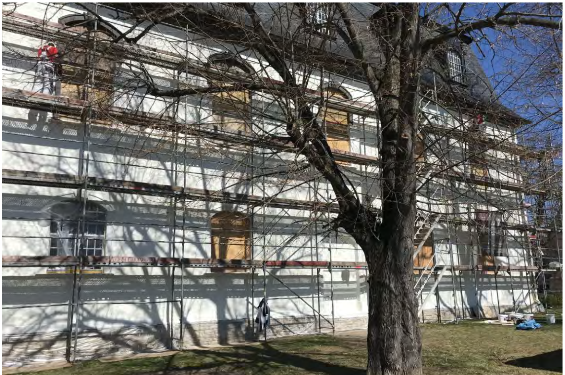
Die Südfassade des Kirchenschiffes während der Malerarbeiten, April 2025.
