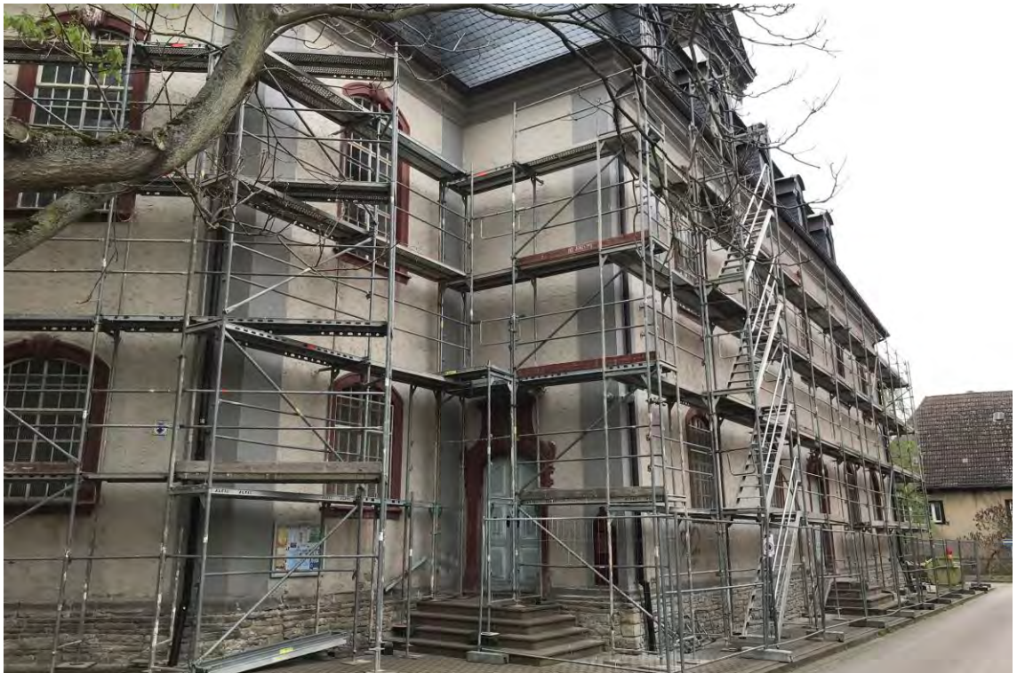
Das Kirchenschiff von Nordosten, mit Abschluss der Instandsetzungsarbeiten an den Südfassaden wurde die Nordseite vom Kirchenschiff eingerüstet, April 2025.
