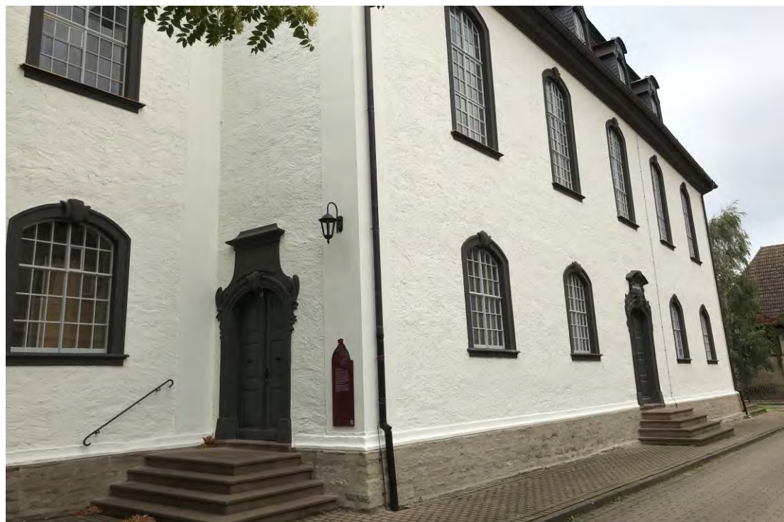
Das Kirchenschiff mit Bauabschluss von Nordosten, Juli 2025.
