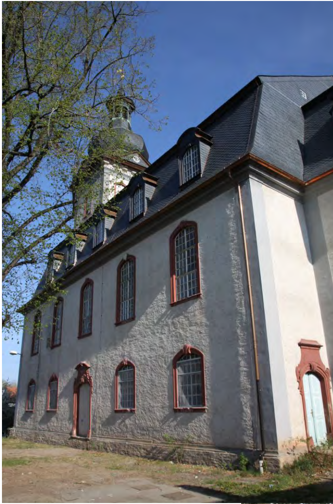
Die Südfassade vom Kirchenschiff vor Baubeginn und
