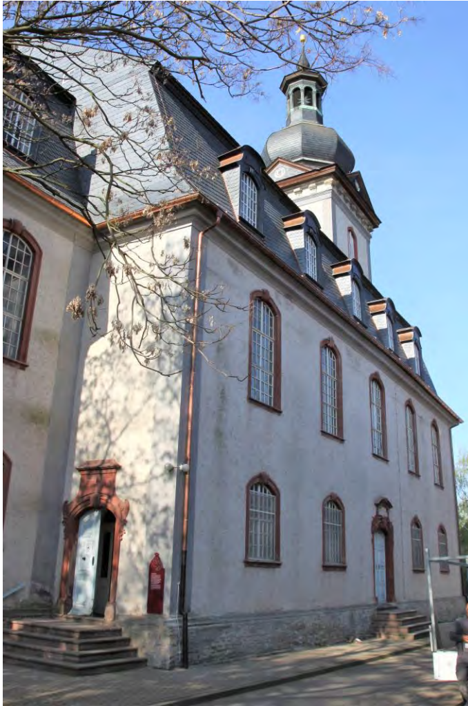
Nordansicht vom Kirchenschiff vor Beginn der Sanierungsarbeiten an den Fassaden und
