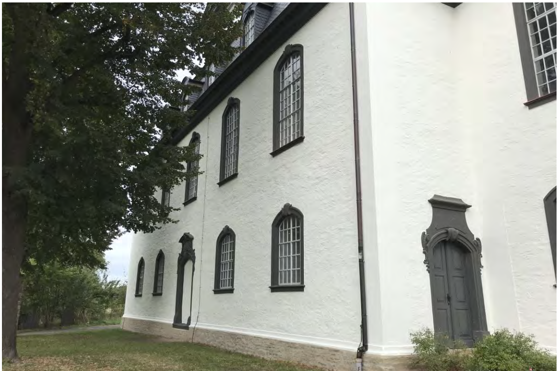
Südwand vom Langhaus mit Bauabschluss von Südosten, Juli 2025.
