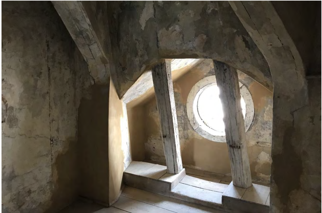
Der restaurierte Hauptraum der ehemaligen Türmerwohnung mit Abschluss der Restaurierungsarbeiten nach Nordwesten, Juni 2023.
