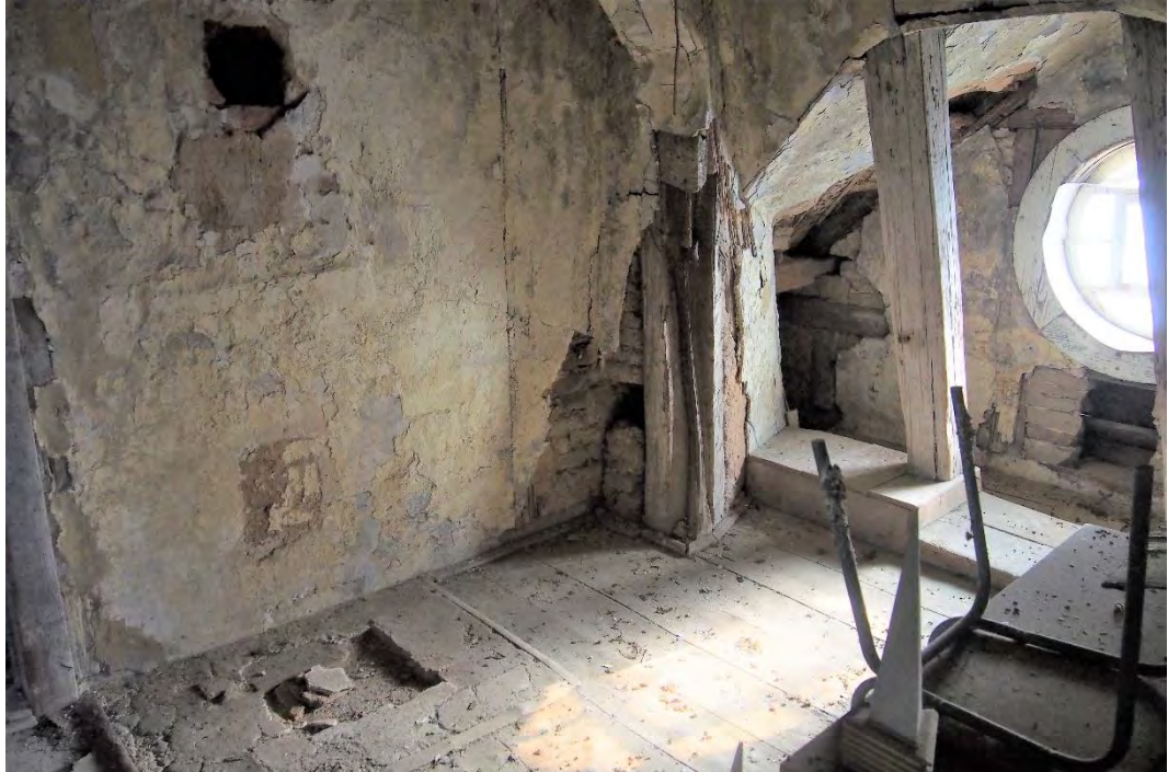
Der Hauptraum der einstigen Türmerwohnung vor Baubeginn und
