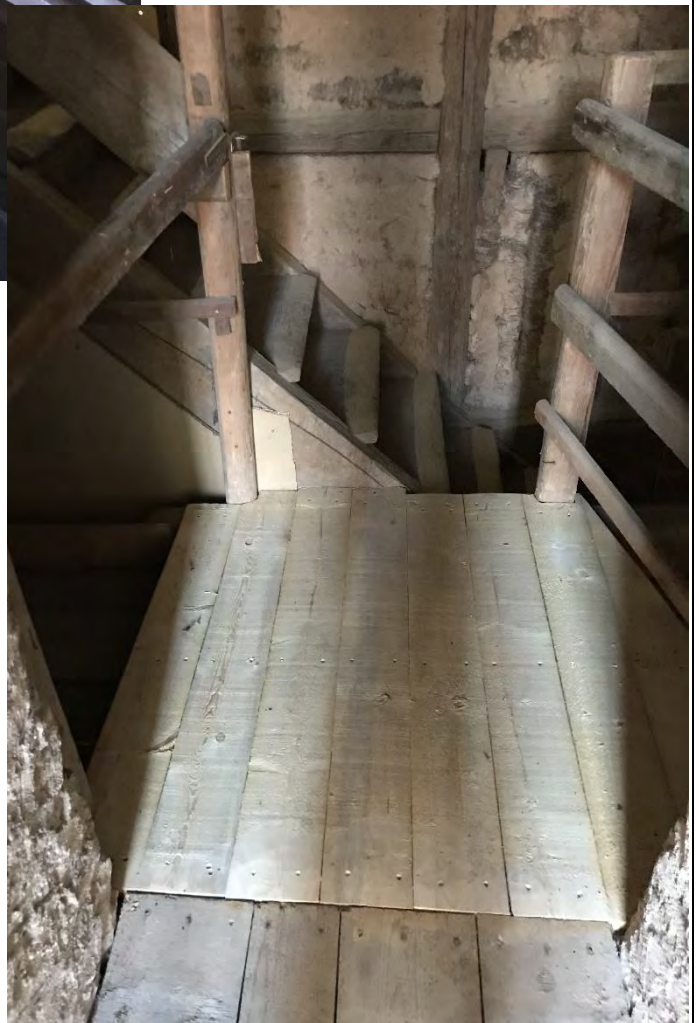
Wiederhergestellter Fußboden im Übergang vom Treppenturn zum Kirchturm, Juni 2023.
