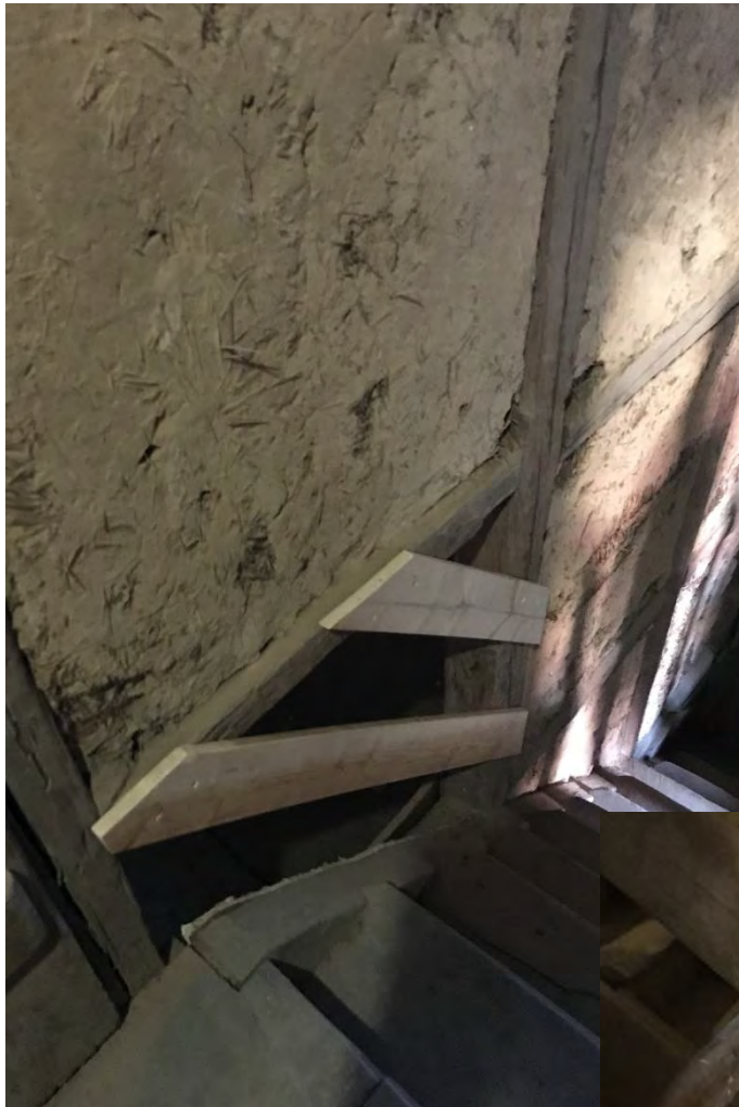
Instand gesetzter und gesicherter Treppenlauf zum Glockengeschoss, Juni 2023.
