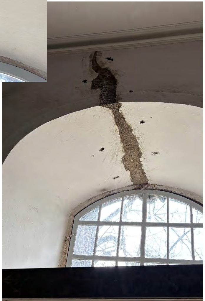
Südwand Langhaus, Sturz zweites unteres Fenster von Osten; mit Nadeln gesicherter und instand gesetzter Sturz, März 2026.
