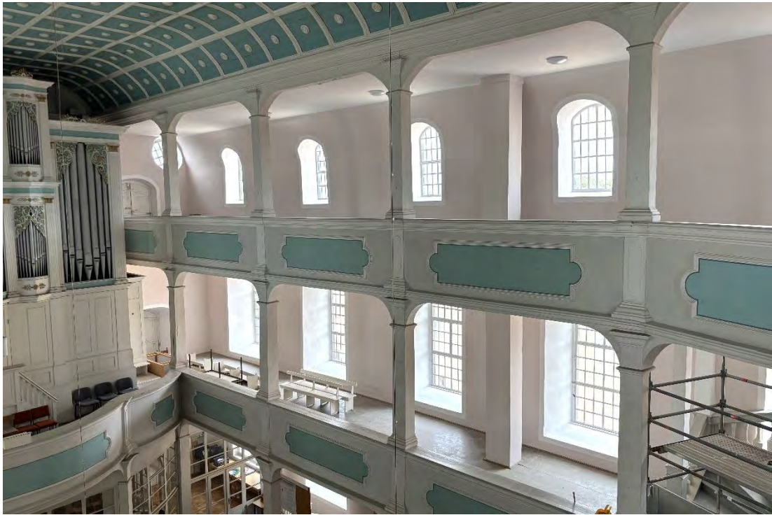
Blick auf die nördlichen Emporen mit Abschluss der Baumaßnahme aus südöstlicher Richtung, Juni 2026.
