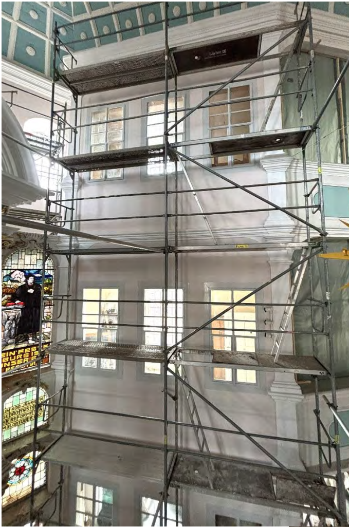
Die südliche Logenwand im Chor während der Restaurierungsarbeiten an den Wandflächen und Fenstern, März 2026.
