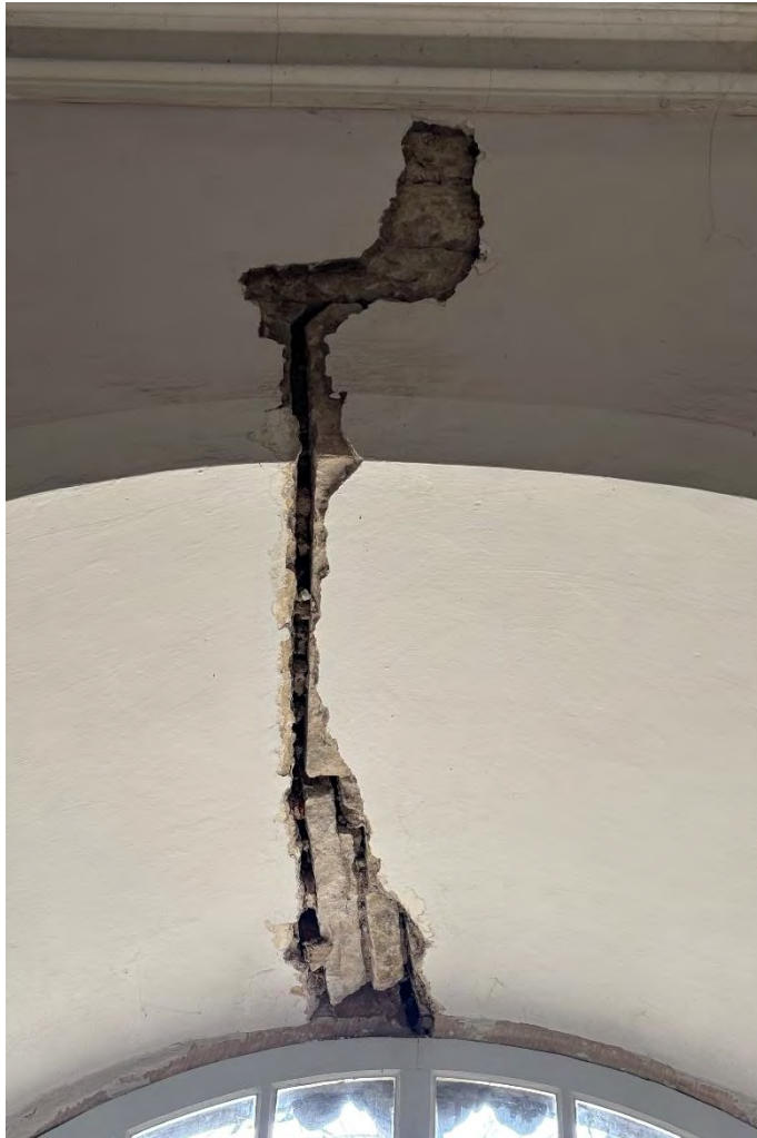
Sturz westliches Fenster 1.OG in der Langhaussüdwand, während der statischen Sicherung und Instandsetzung, April 2026.
