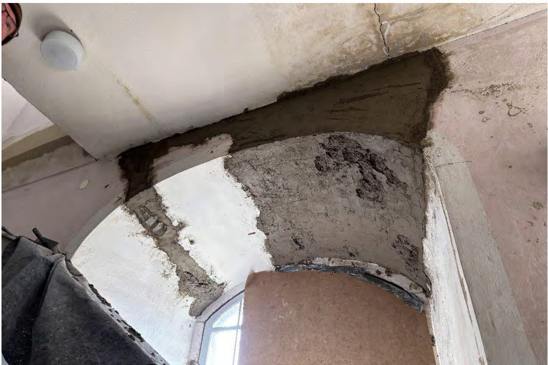
Langhaussüdwand, Sturzbereich östliches Fenster 1.OG, während des Verputzes der Risschäden, April 2026.
