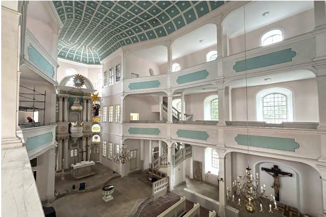
Der Innenraum der St. Johannis Kirche mit Abschluss der Sanierungsarbeiten nach Südosten, Juni 2026.
