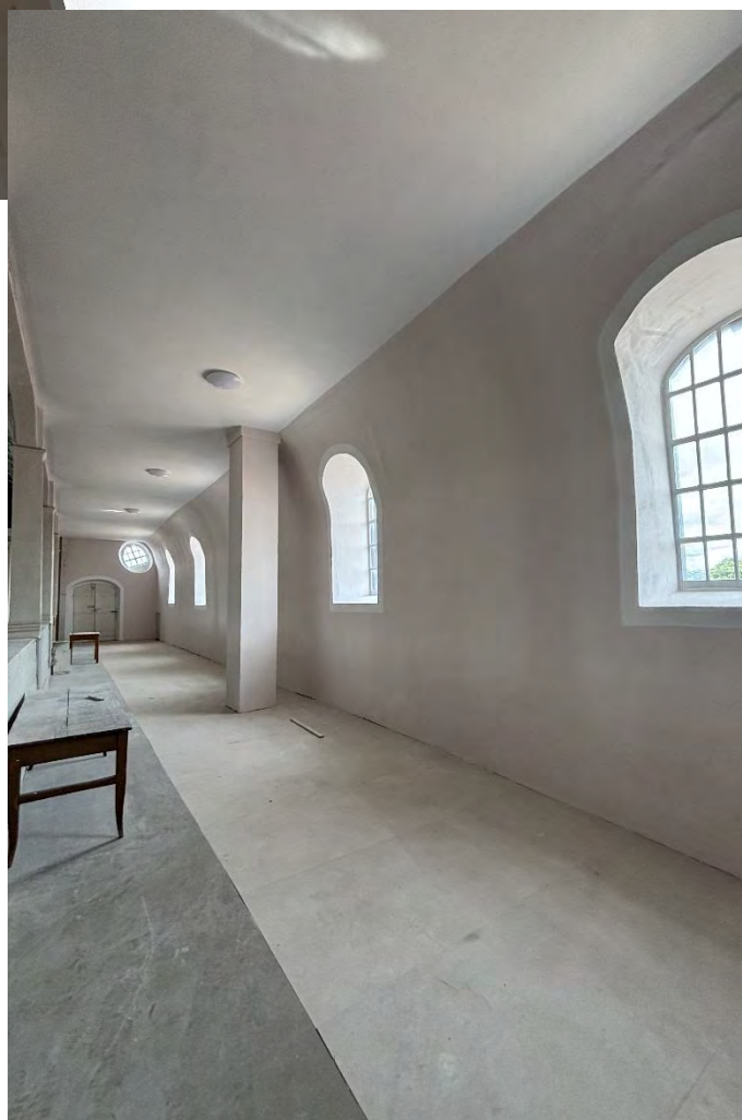
Die obere nördliche Empore nach Westen, instand gesetzte und farblich neu gefasste Decke und Wand, Juni 2026.
