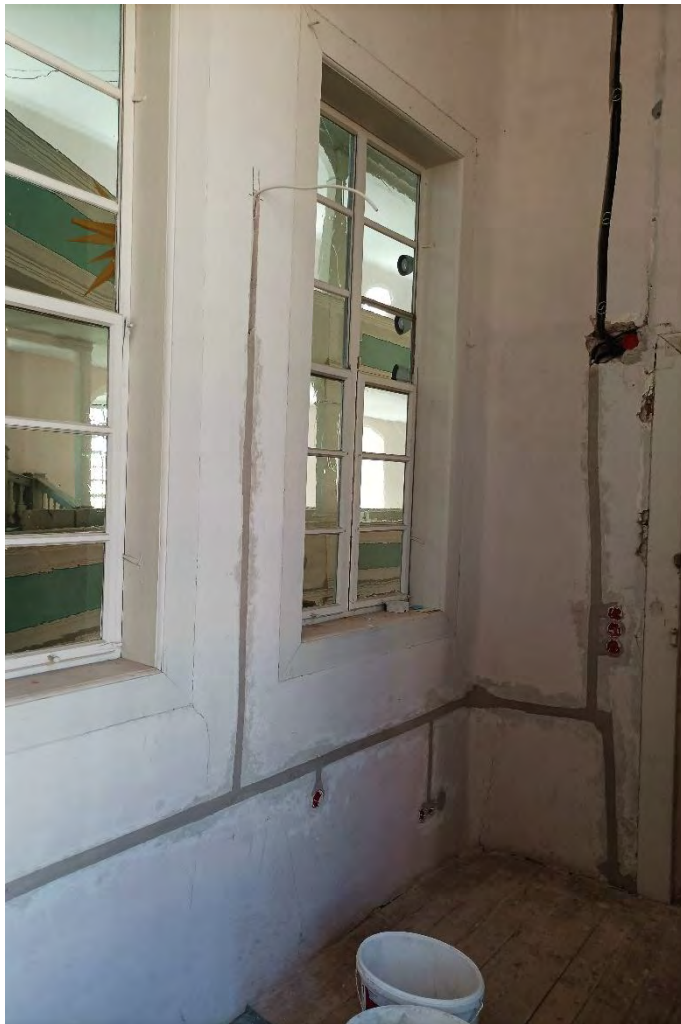
Die mittlere nördliche Loge während der Elektroinstallation, nach Westen, April 2026.
