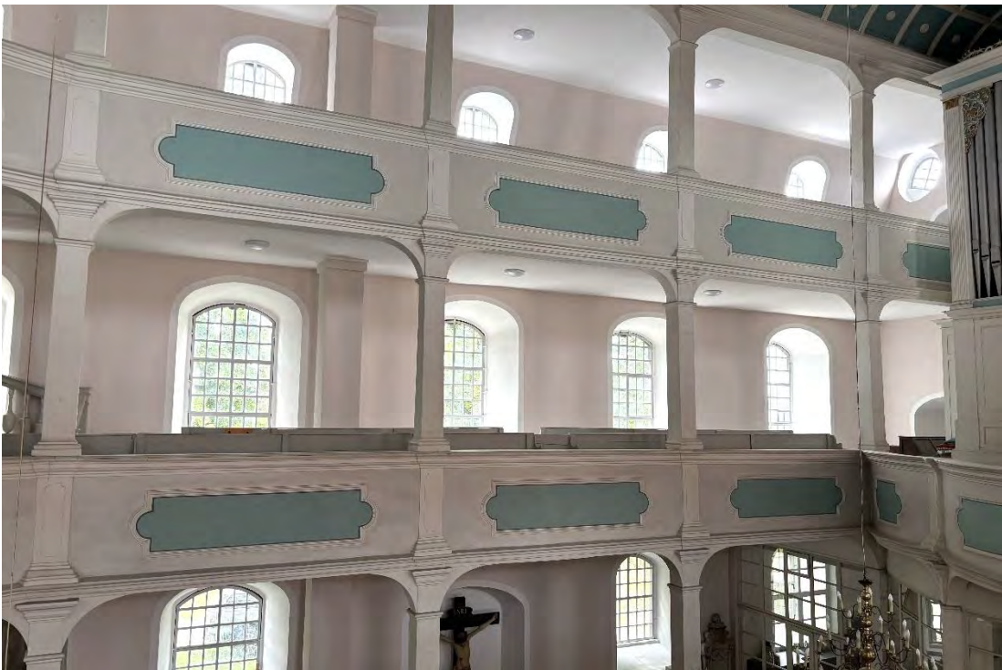
mit Abschluss der Sanierungsarbeiten im Juni 2026.
