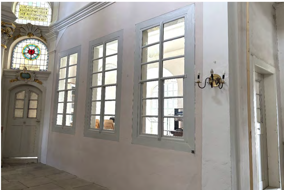
Die Chorseite der unteren südlichen Loge mit Bauabschluss nach Südosten, Juni 2026.
