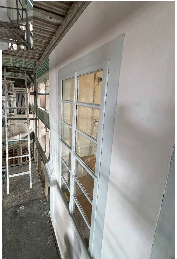
Nördliche Logenwand, oberes westliches Fenster nach der Restaurierung, März 2026.
