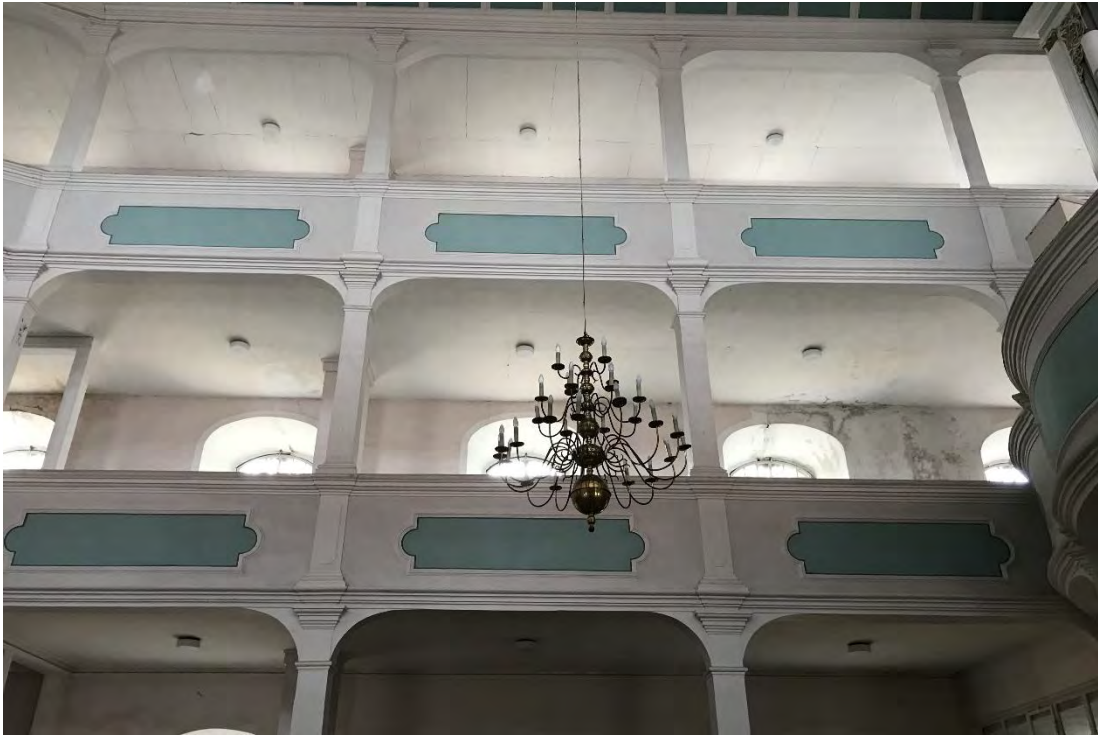
Die Südemporen vor Baubeginn und
