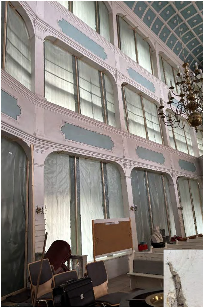
Die Südempore nach Südwesten; zum Schutz des Innenraumes vor Verschmutzungen und Staubein- wirkungen wurden die Emporen an den Innenseiten mit Folie staubdicht abgedichtet, Februar 2026.
