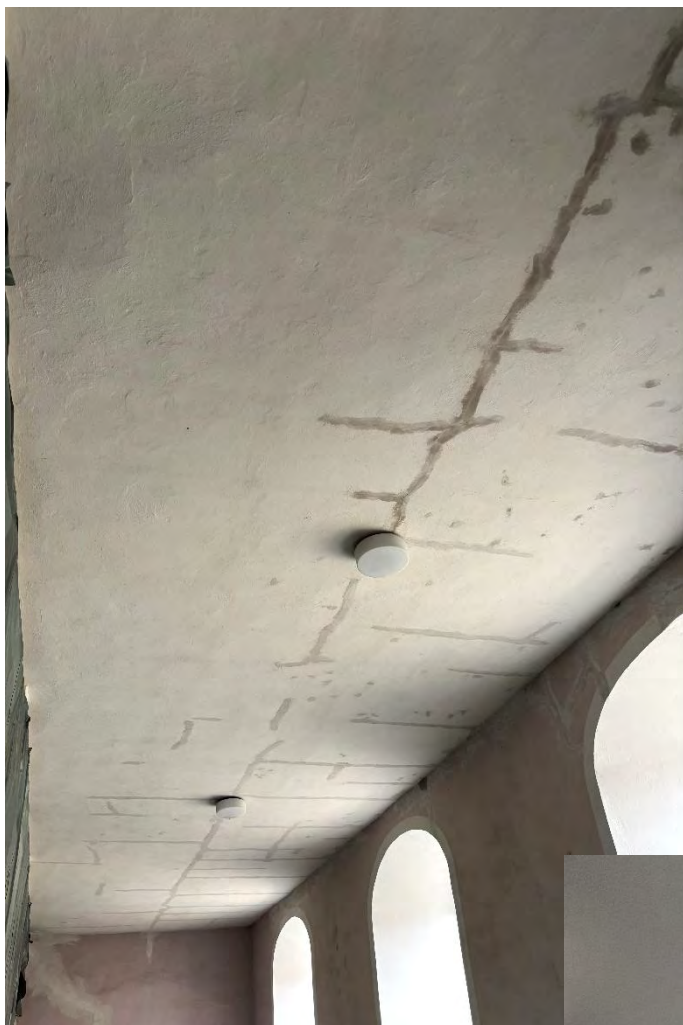
Decke 1.Empore während der Instandsetzung, nach Westen, aufgenommen im Mai 2026.
