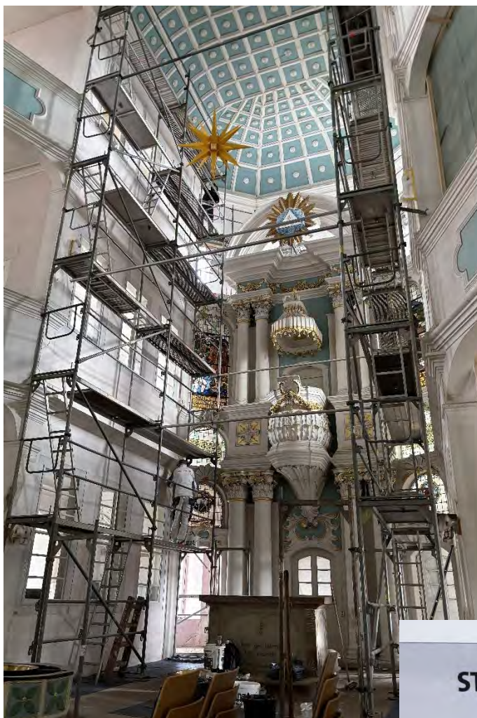
Die eingerüsteten Logenfronten im Chor zu Beginn der Sanierungsarbeiten, nach Nordosten, Februar 2026.
