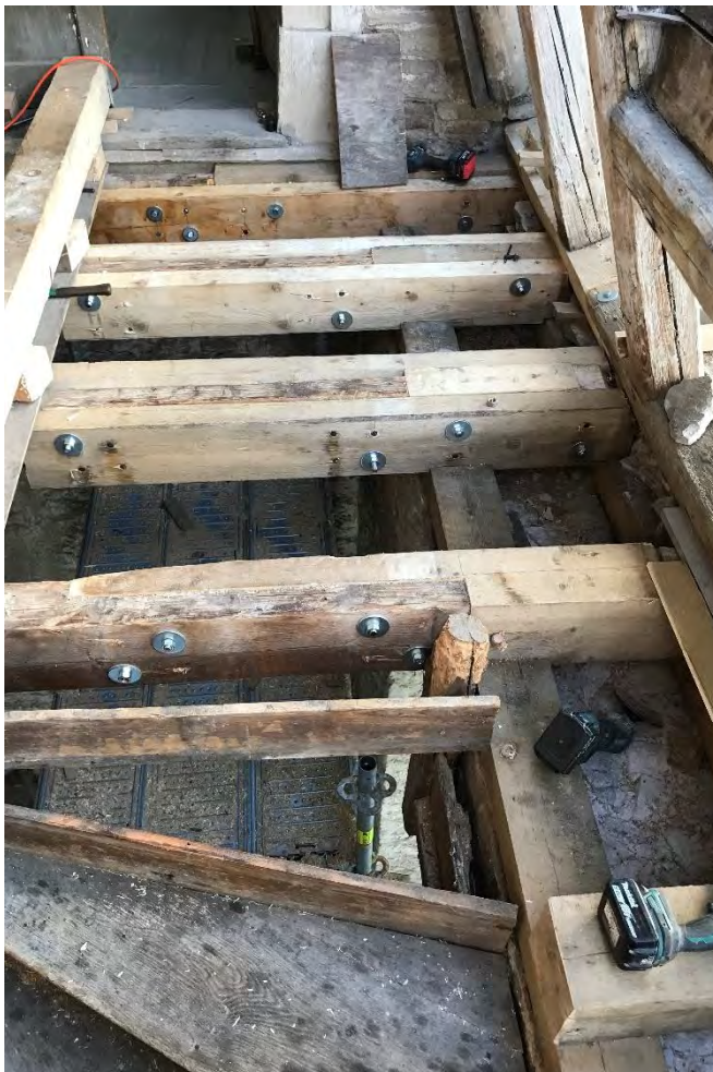
Der südliche Auflagerbereich mit sanierten Deckenbalken, nach Osten, Februar 2022.
