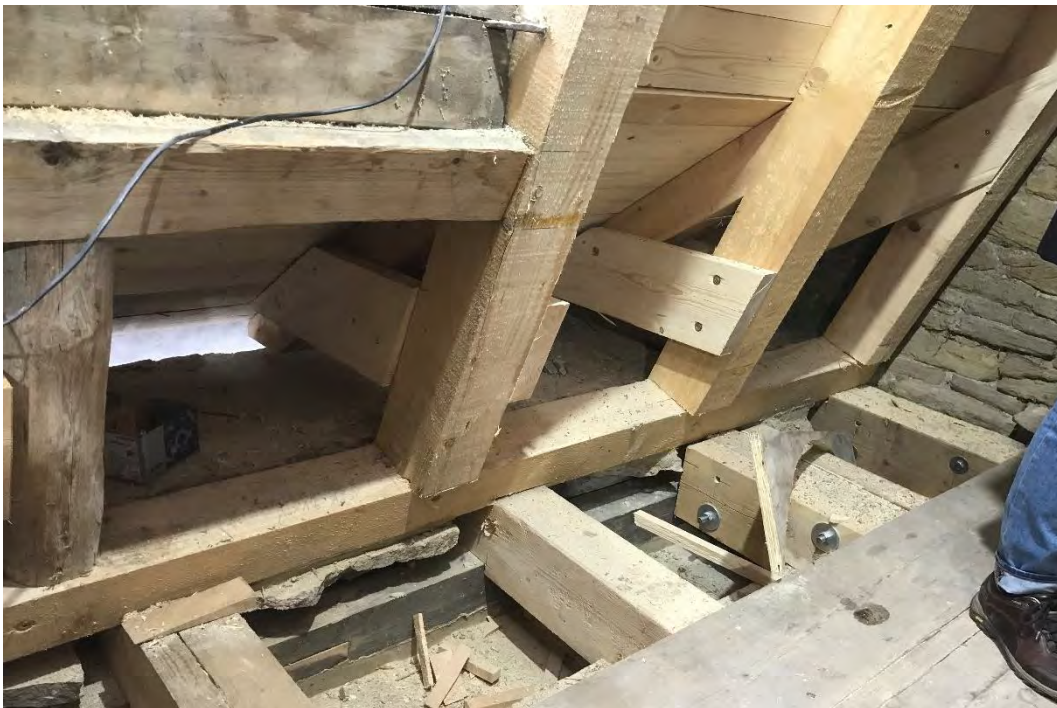
Der instand gesetzte nördliche Auflagerbereich, nach Norden; erneuerte Hölzer, zur Entlastung des Hauptgesimses wurden Spreizen mit Laschen zwischen Sparren und Aufschieber eingebaut, Dezember 2021.
