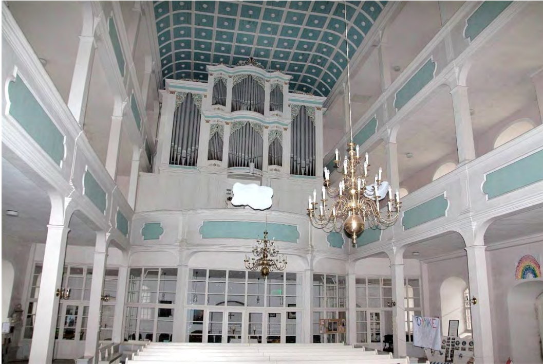
Blick in das von einer kassettierten Muldendecke überspannte Langhaus nach Westen; der Innenraum wird wesentlich durch die an den Langwänden zweistöckige Empore und den Orgelprospekt auf der Westempore bestimmt, unter der Westempore ist eine Winterkirche eingerichtet, November 2018.
