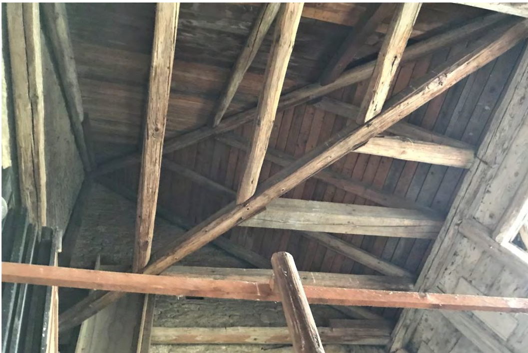
Blick in das Oberdach vom südlichen Turmanbau, Dezember 2018.
