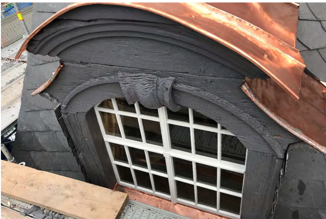
Dachgaube südlicher Turmanbau mit Bauabschluss, März 2022.
