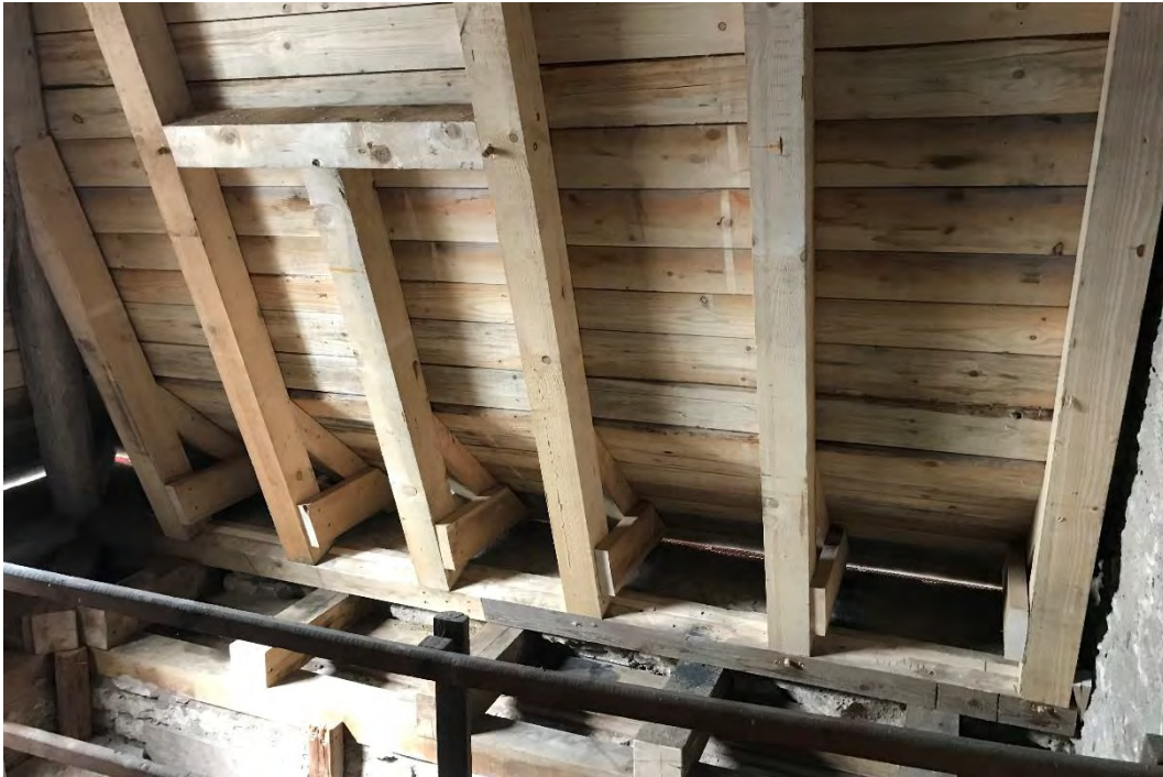
Südlicher Turmanbau, saniertes westliches Unterdach nach Westen, März 2022.
