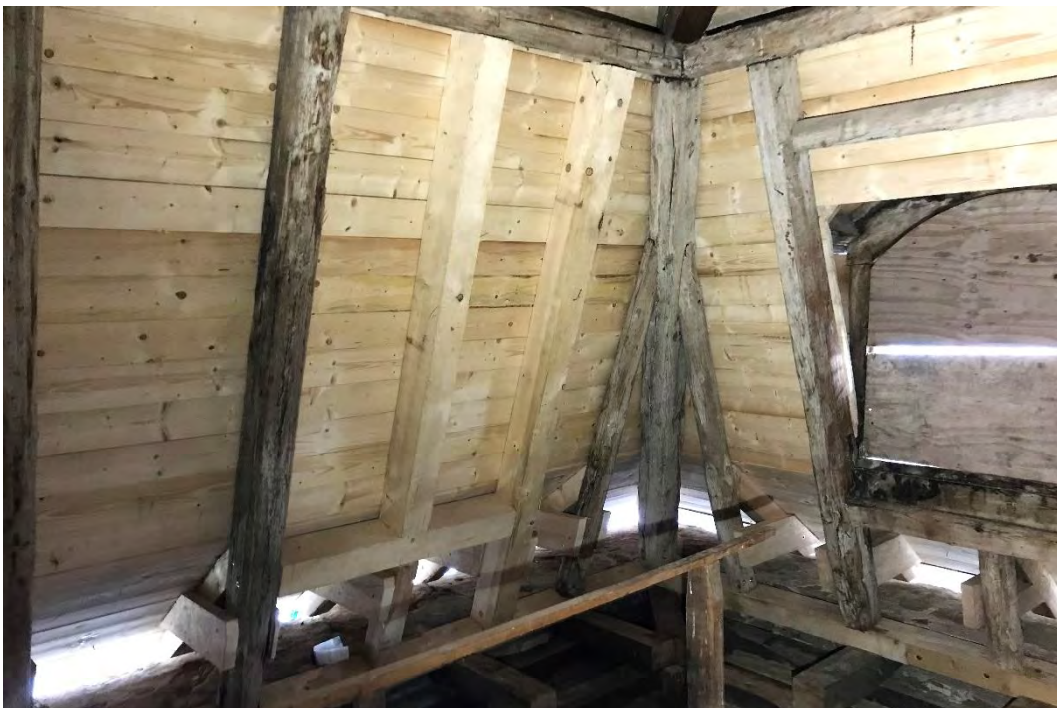
Nördlicher Turmanbau, instand gesetzte Holzkonstruktion vom Unterdach nach Nordwesten, Dezember 2021.
