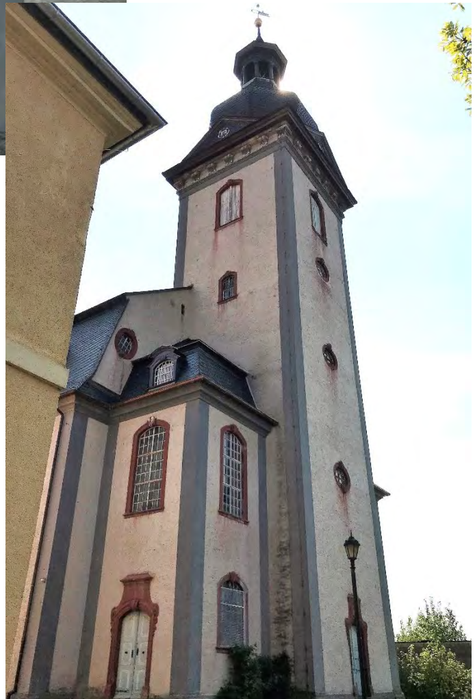
Kirchturm und nördlicher Turmanbau mit Bauabschluss aus nordwestlicher Richtung, April 2022.
