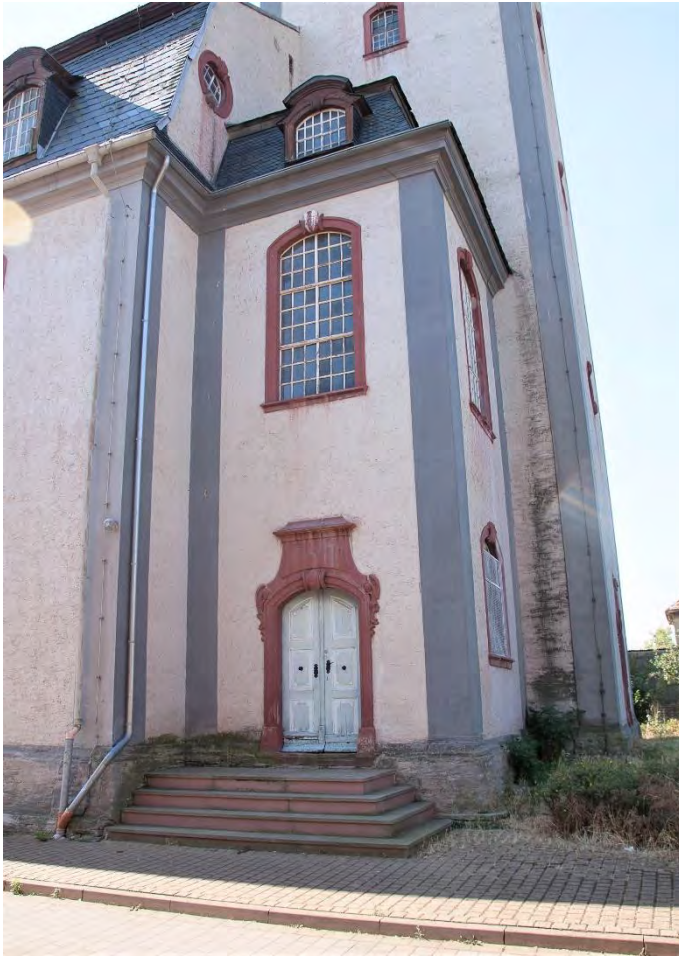
Der nördliche Anbau mit dem Treppenaufgang zur Empore, nach Süden, Juli 2018.
