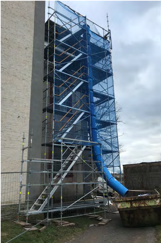
Der eingerüstete südliche Turmanbau nach Südosten, Januar 2022.
