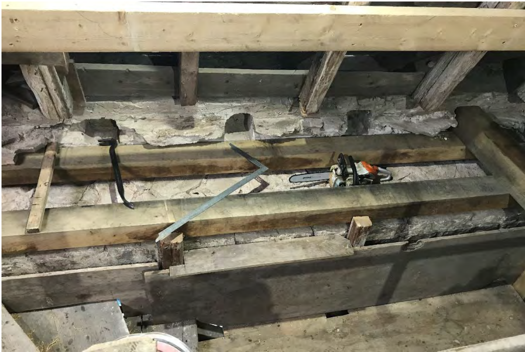
Westliche Mauerkrone vom südlichen Turmanbau während der Holzinstandsetzung; in die offenen Kanäle im Hauptgesims wurden die neuen Stichbalken eingeführt, Februar 2022.
