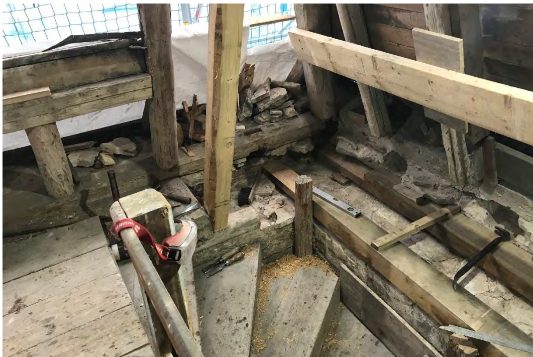
Der Traufbereich vom Dach des südlichen Turmanbaues während der Sanierungsarbeiten, nach Südwesten, Februar 2022.
