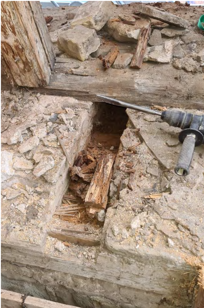
Westliche Mauerkrone, Detailaufnahme aufgelöster Stichbalken; die Stichbalken wurden in dem Hauptgesims eingemauert, November 2021.
