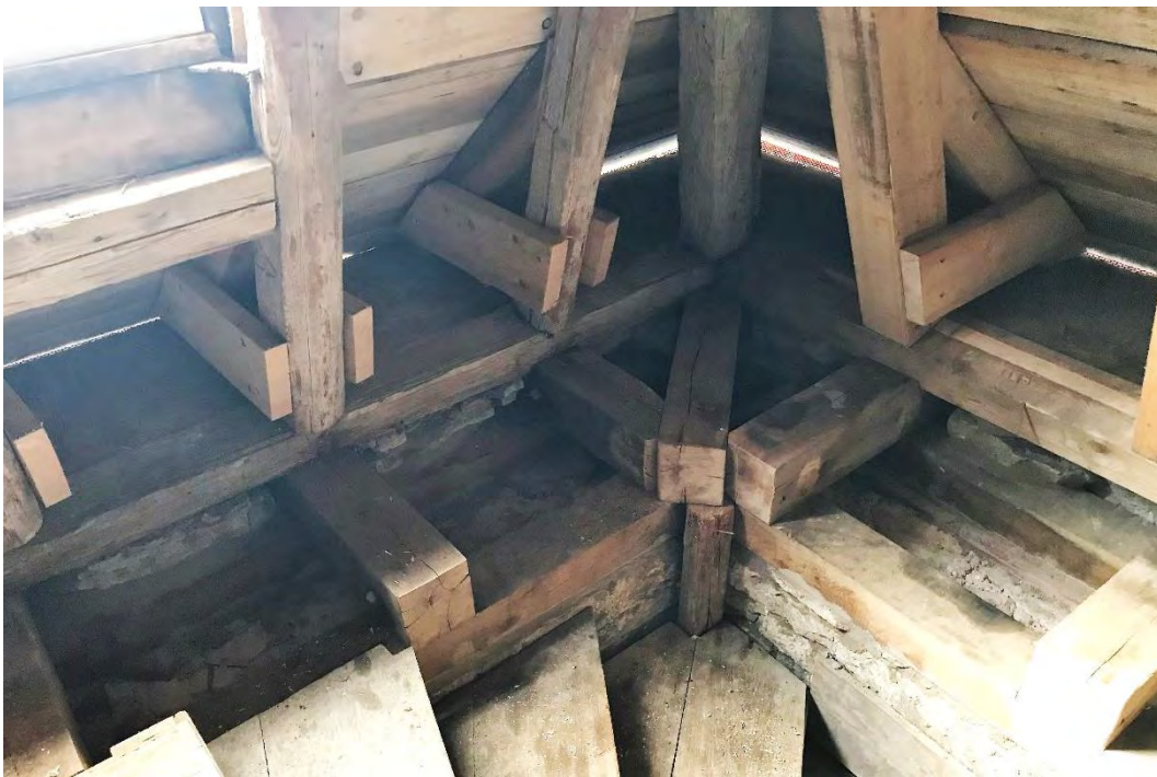
Blick in die Südwestecke vom sanierten Auflagerbereich, März 2022.
