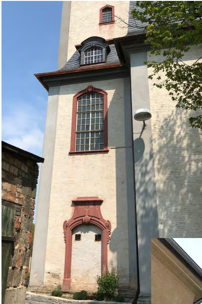
Der südliche Turmanbau mit Abschluss der Bauarbeiten nach Norden, aufgenommen im April 2022.
