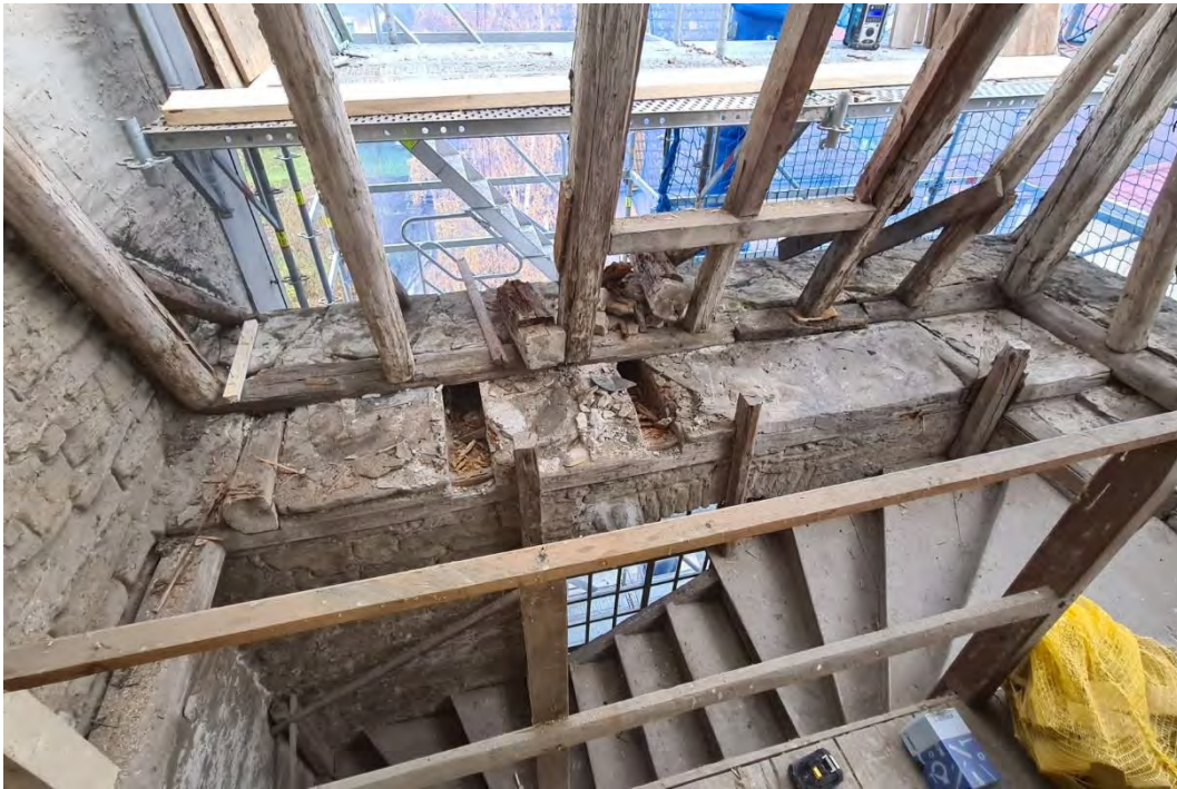
Die freigelegte und gereinigte westliche Traufe vom nördlichen Anbau nach Westen; Stich- und Mauerbalken sind komplett eingemauert, aufgenommen im Juli 2020.
