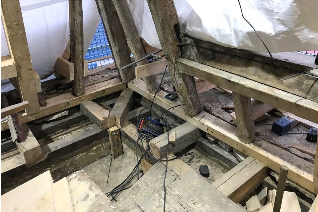
Die Holzkonstruktion im Auflagerbereich vom nördlichen Turmanbau nach Nordwesten; sämtliche Mauerbalken und Stichbalken sowie Sparrenschwellen mussten erneuert werden, Dezember 2021.
