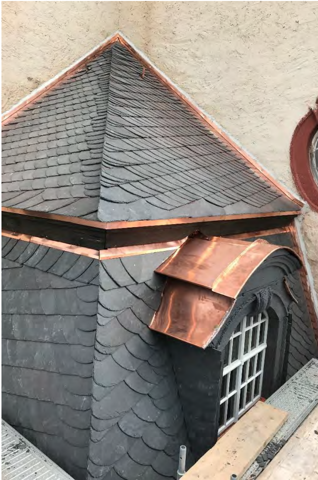
Das neu verschieferte Dach vom südlichen Turmanbau mit Bauabschluss nach Nordosten, März 2022.
