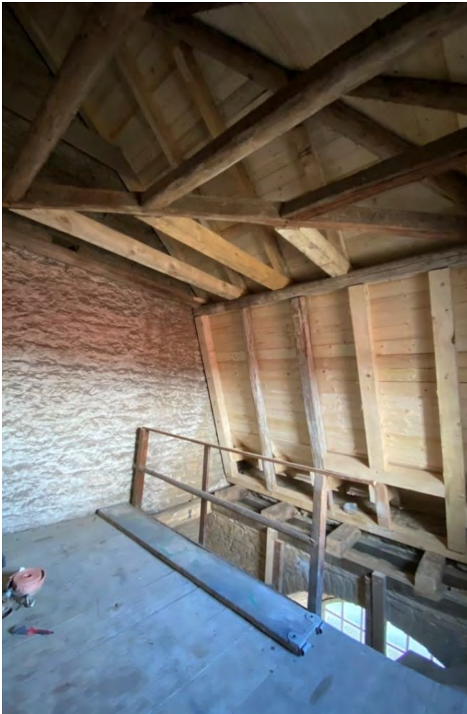
Blick in den Dachraum vom nördlichen Anbau mit Abschluss der Holzinstandsetzung nach Südwesten, Dezember 2021.
